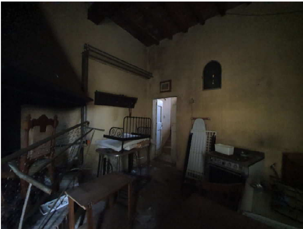
FOTO 04 – Ripresa fotografica del vano di accesso
