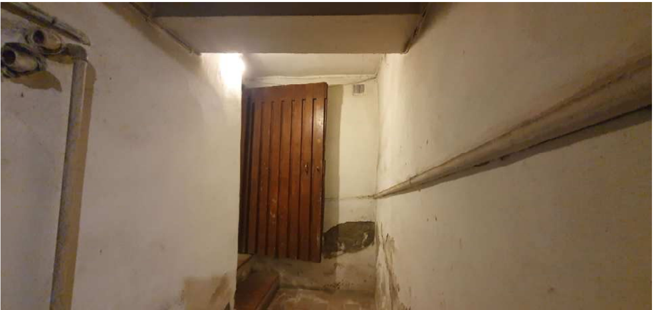
FOTO 32 – Ripresa fotografica dell'accesso al vano tecnico dal disimpegno delle cantine
