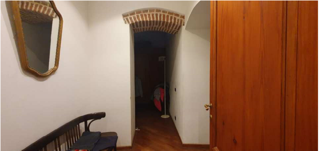
FOTO 19 – Ripresa fotografica del disimpegno della camera padronale con a sinistra muretto non dichiarato per la formazione di un ripostiglio ed in fondo un varco non dichiarato che porta a guardaroba realizzato nella porzione a funzione agricola dell'immobile
