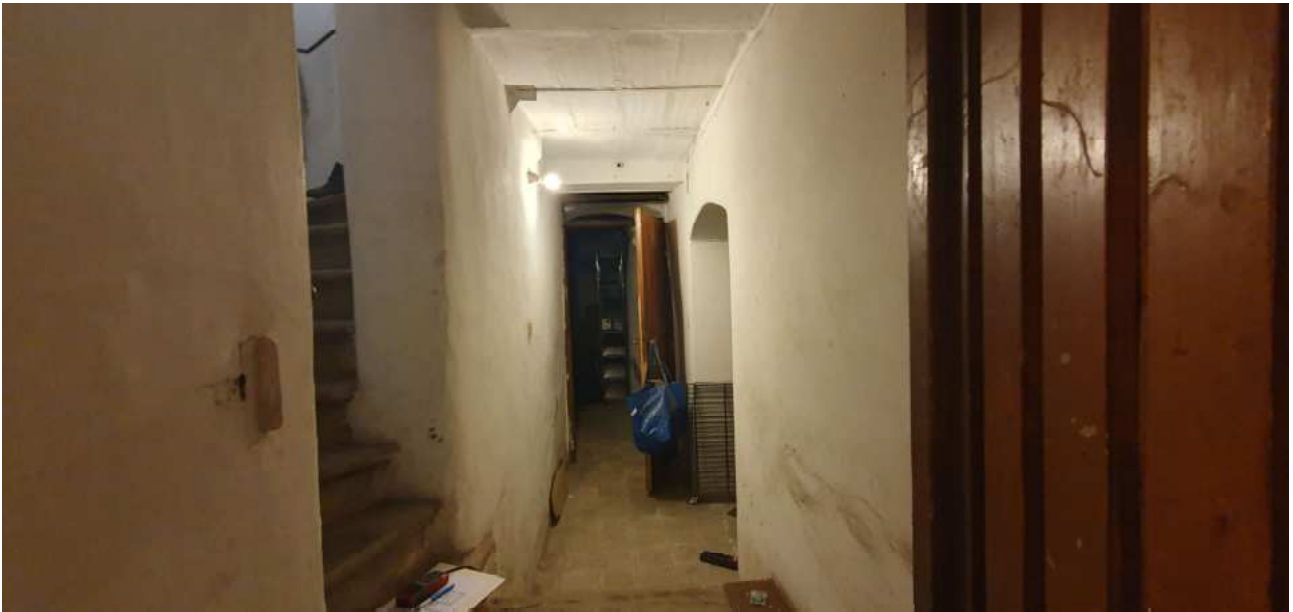
FOTO 27 – Ripresa fotografica del disimpegno delle cantine
