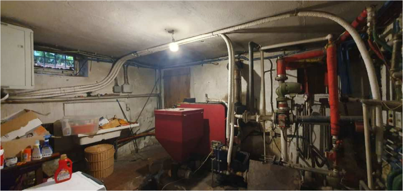
FOTO 33 – Ripresa fotografica del vano tecnico. In fondo vi è un accesso diretto ad una unità immobiliare a funzione agricola
