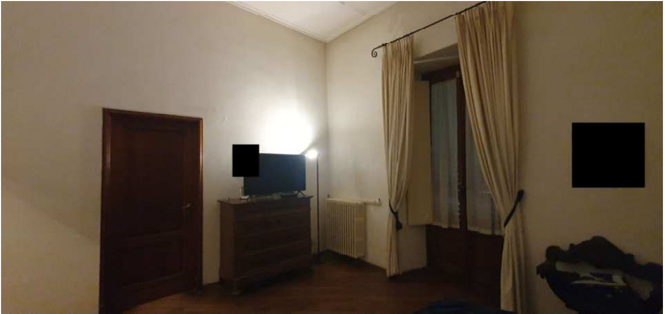
FOTO 21 – Ripresa fotografica della camera padronale con la presenza di varco non dichiarato che porta a servizio igienico realizzato nella porzione a funzione agricola dell'immobile
