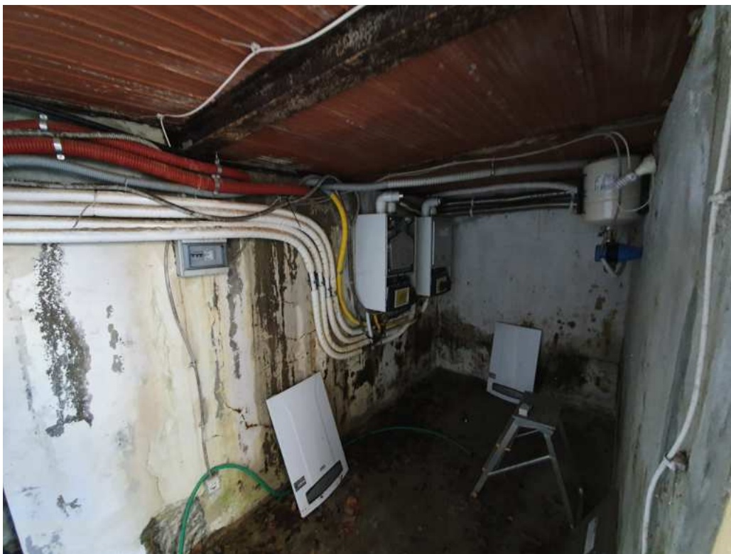
FOTO 17 – Ripresa fotografica dei vani tecnici interrati (non oggetto di esecuzione)
