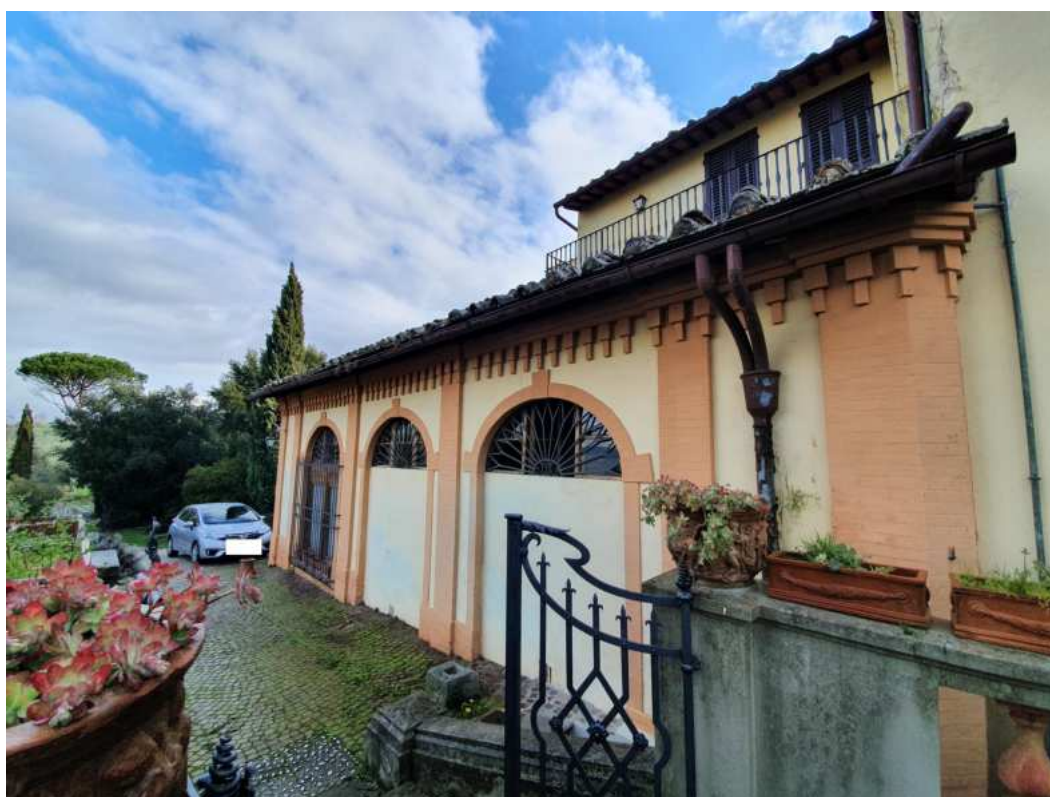
FOTO 14 – Ripresa fotografica dell'esterno che porta ai vani tecnici interrati (non oggetto di esecuzione)
