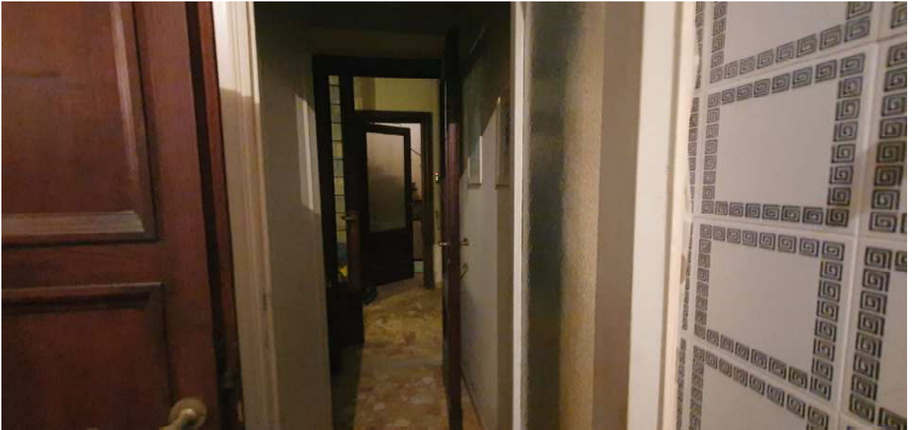
FOTO 15 – Ripresa fotografica del disimpegno del servizio igienico
