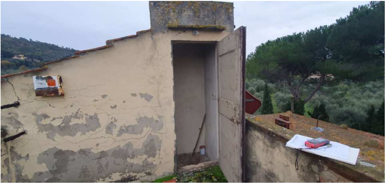
FOTO 29 – Ripresa fotografica dell'uscita sulla terrazza in copertura
