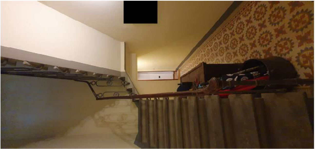
FOTO 05 – Ripresa fotografica del vano scale “a comune” di accesso ai beni oggetto di perizia
