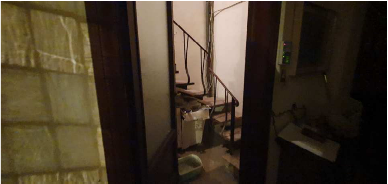
FOTO 27 – Ripresa fotografica della scala che conduce alla terrazza in copertura
