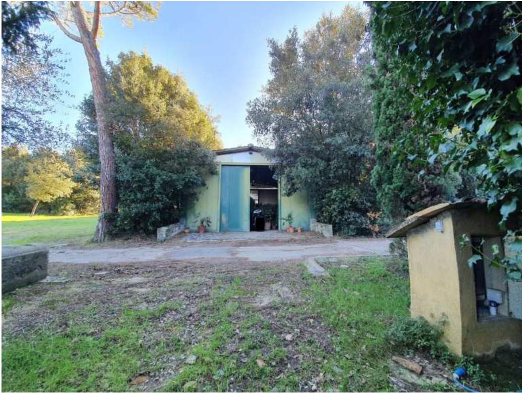
FOTO 25 – Ripresa fotografica deposito senza titolo edilizio ed oggetto di ordinanza di demolizione
