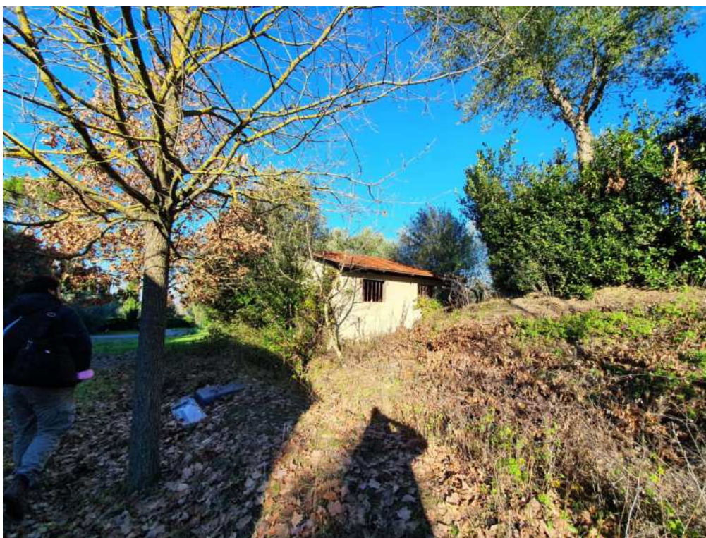
FOTO 22 – Ripresa fotografica ex stalle oggetto di demolizione
