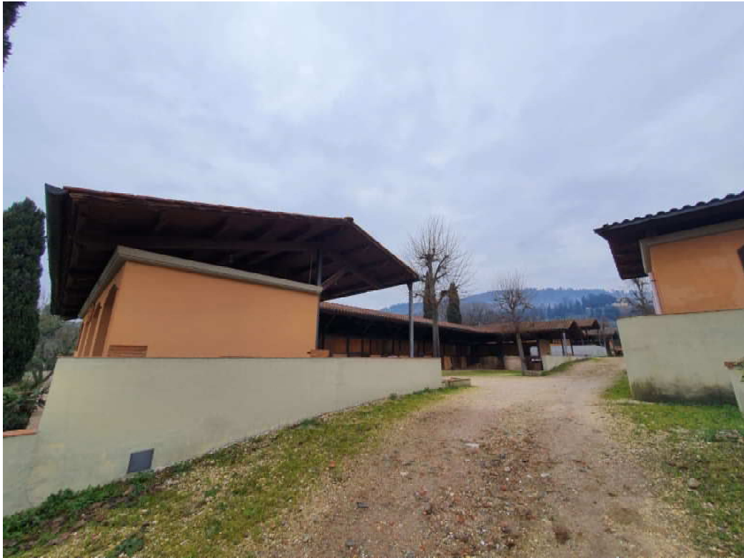
FOTO 03 – Ripresa fotografica blocco A Maneggio/stalla
