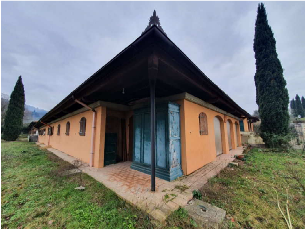
FOTO 09 – Ripresa fotografica blocco A Maneggio/stalla (retro)
