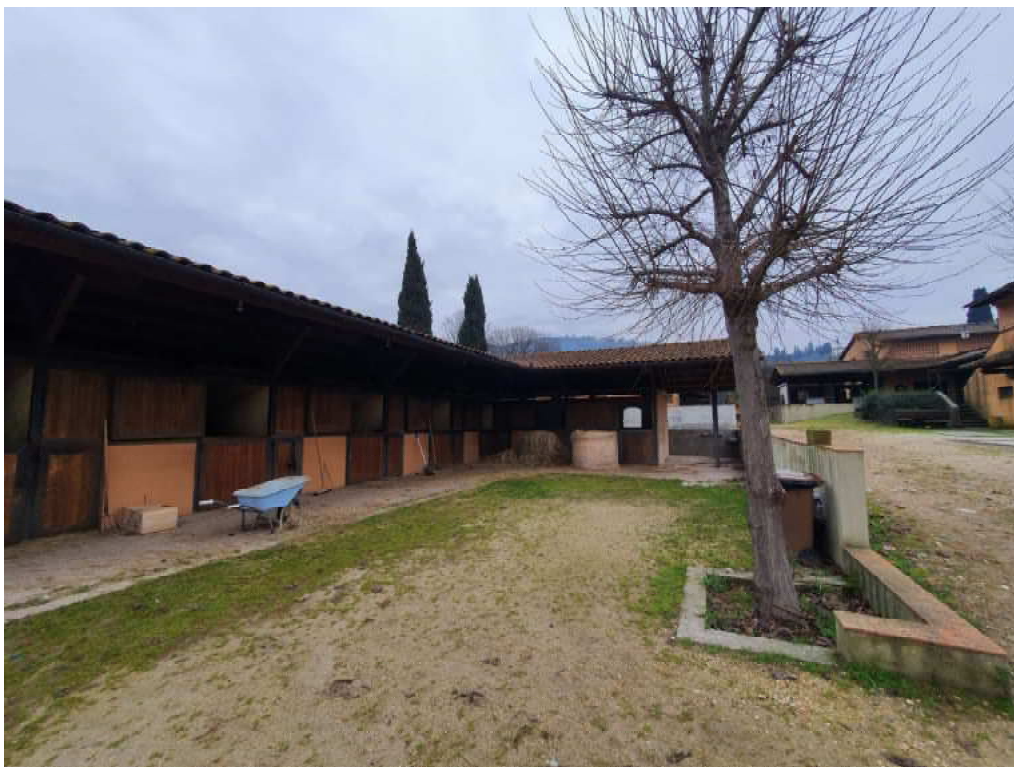
FOTO 05 – Ripresa fotografica blocco A Maneggio/stalla
