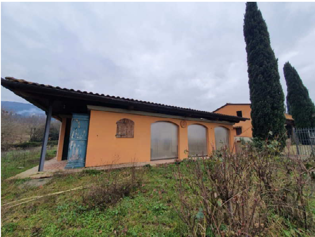
FOTO 10 – Ripresa fotografica blocco A Maneggio/stalla
