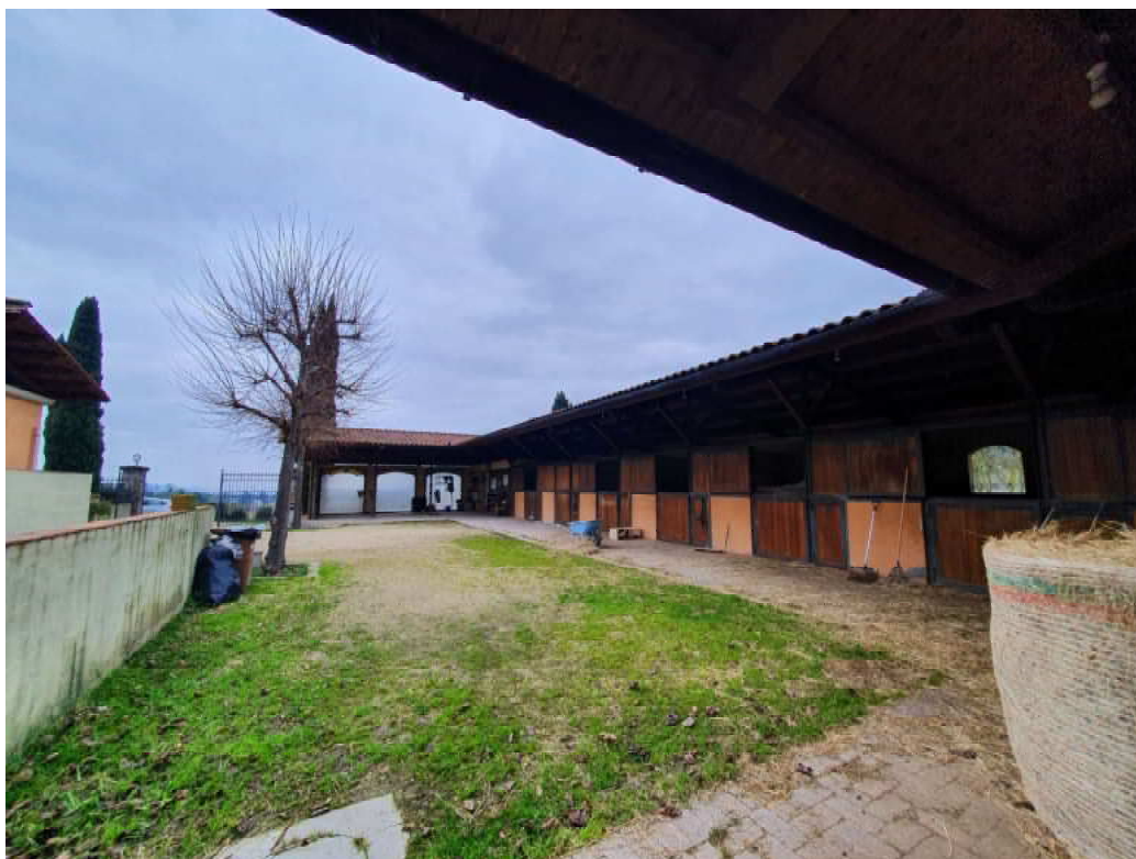
FOTO 06 – Ripresa fotografica blocco A Maneggio/stalla
