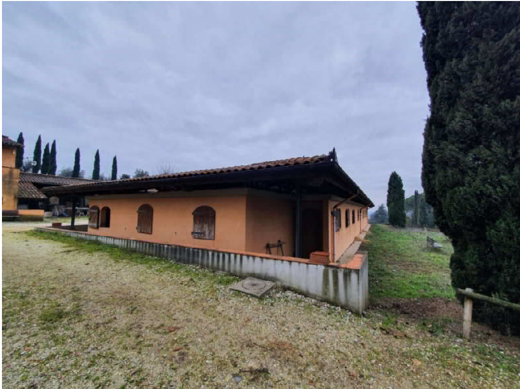
FOTO 07 – Ripresa fotografica blocco A Maneggio/stalla (retro).
