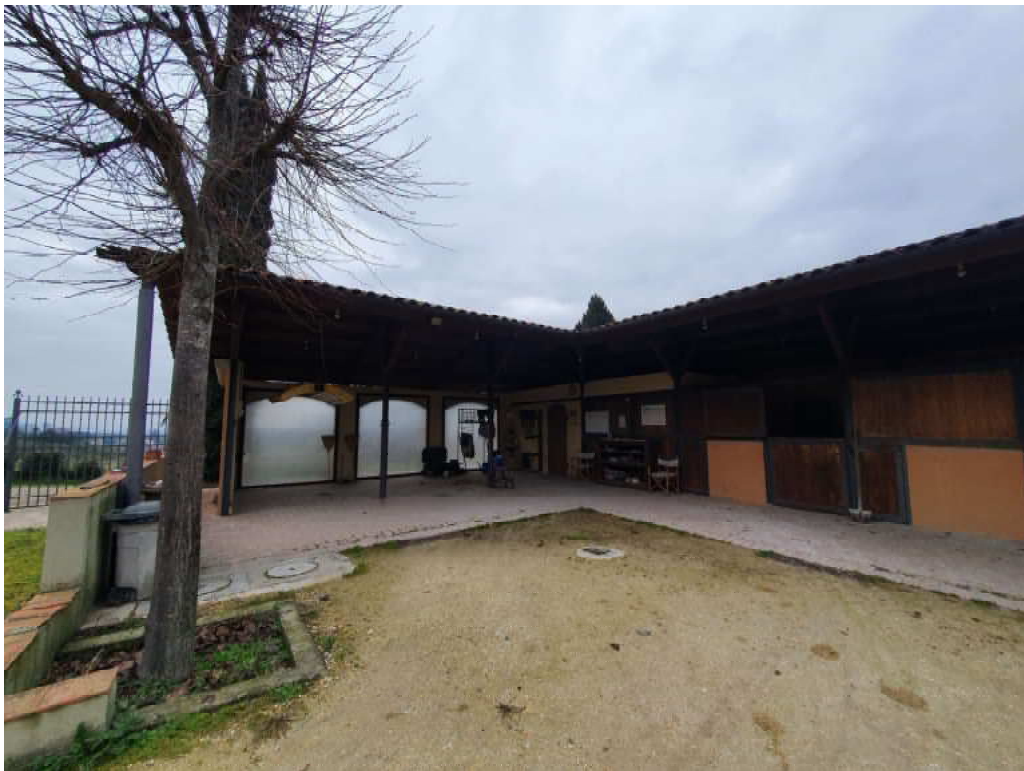
FOTO 04 – Ripresa fotografica blocco A Maneggio/stalla
