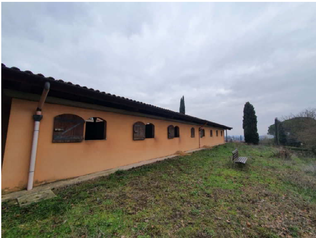
FOTO 08 – Ripresa fotografica blocco A Maneggio/stalla (retro).
