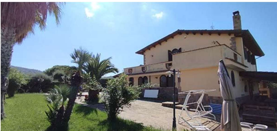
imm2.14: vista laterale del fabbricato e del giardino
