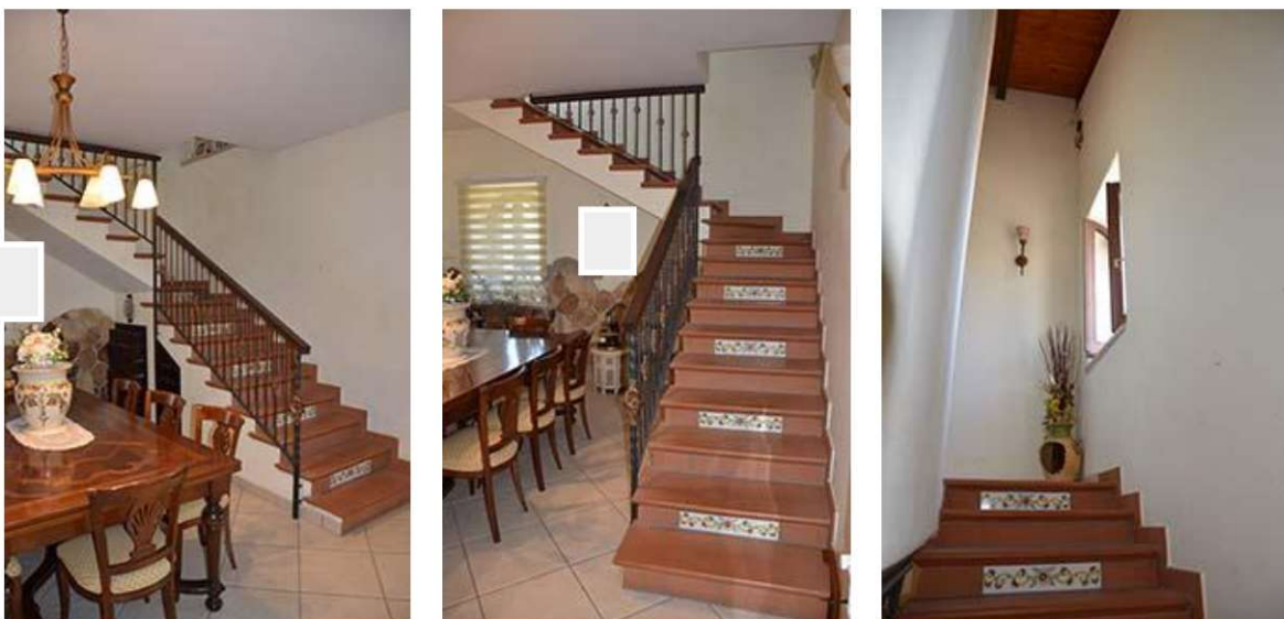
imm2.28: scala interna al primo piano
