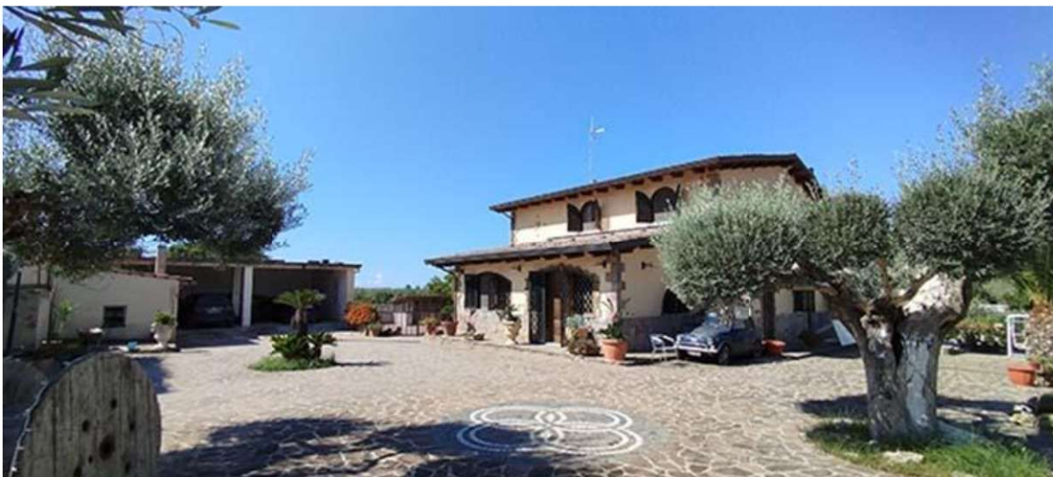
imm2.13: vista del fabbricato e dello spazio esterno
