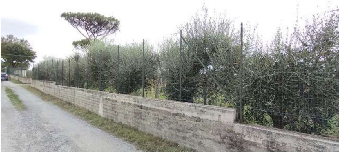
imm2.58: confine del terreno sul lato di ingresso
