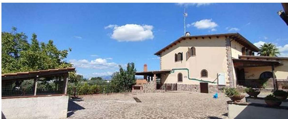
imm2.18: vista dal cortile esterno
