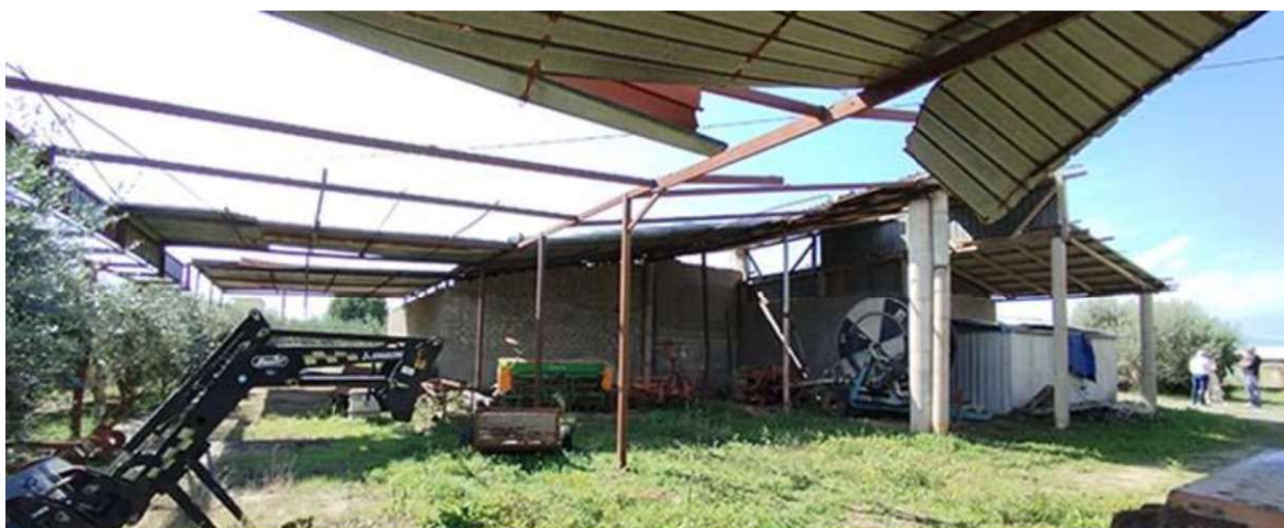
imm2.50: tettoia esterna
