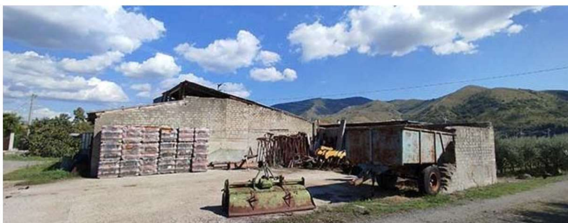
imm2.52: area di risulta tettoia rimossa
