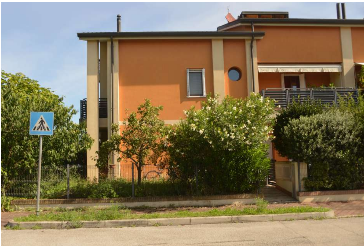
Foto n.19 particolare fronte Sud
