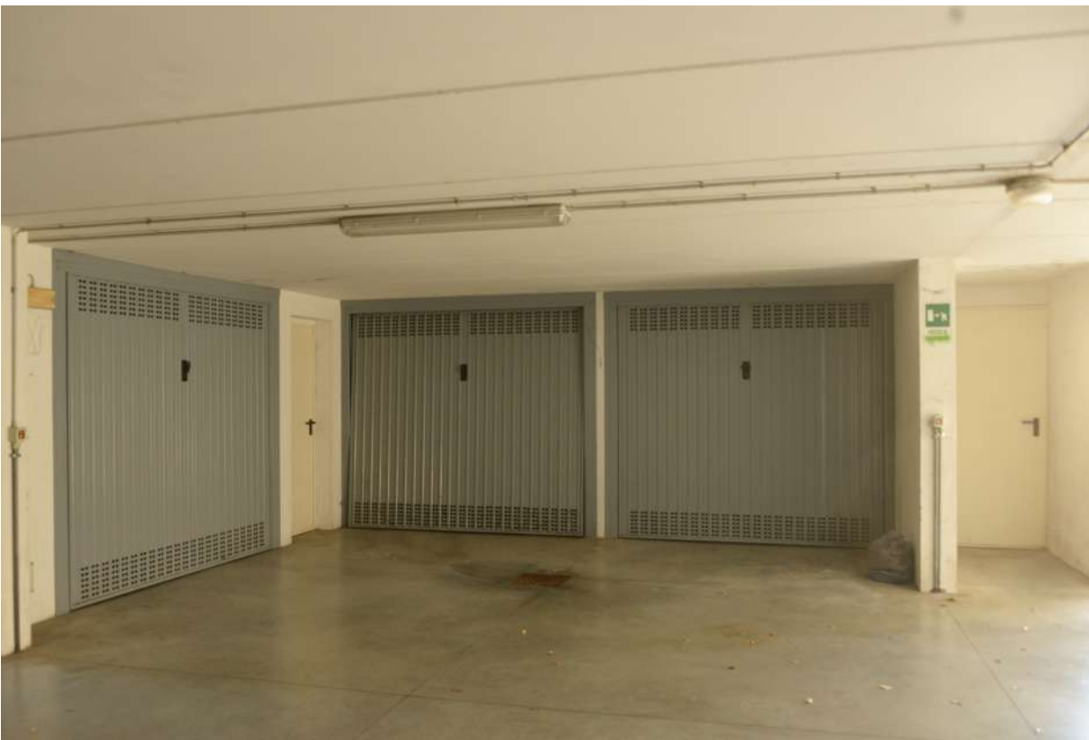
Foto n. 32 - Piano interrato area di manovra autorimesse
