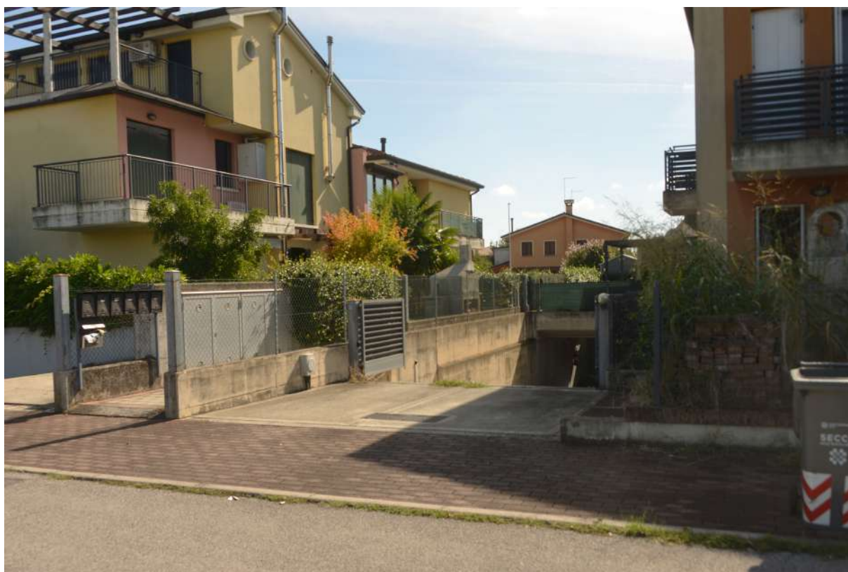
Foto n. 26 – accesso rampa d'accesso autorimesse
