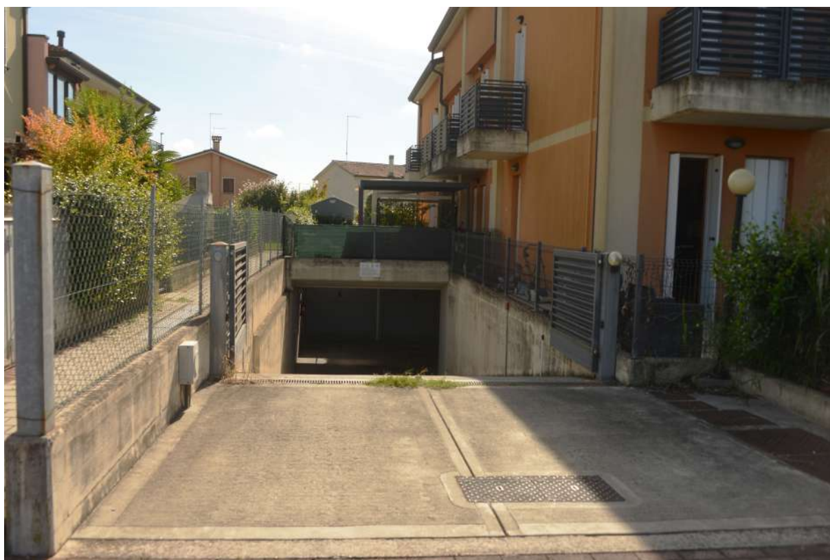
Foto n. 27 – rampa d'accesso autorimesse
