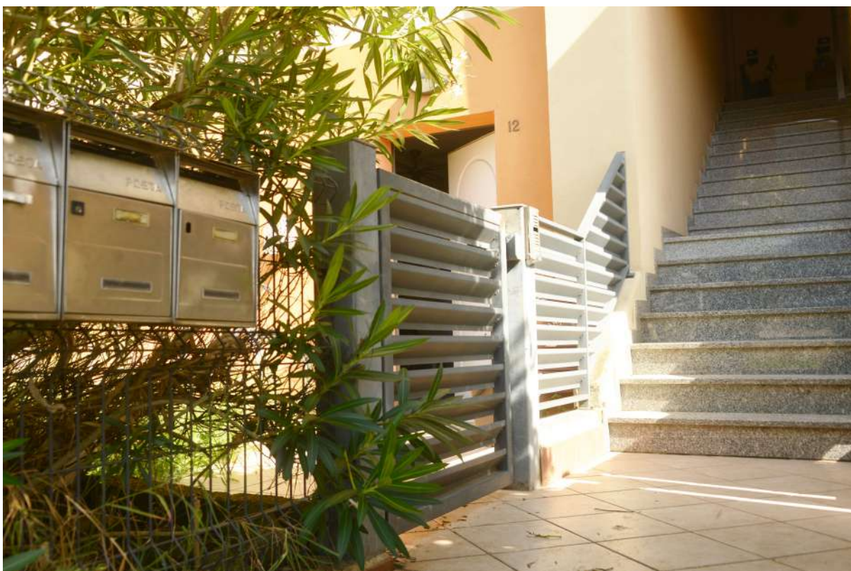
Foto n. 20 cancello pedonale esterno di ingresso abitazione sub 4
