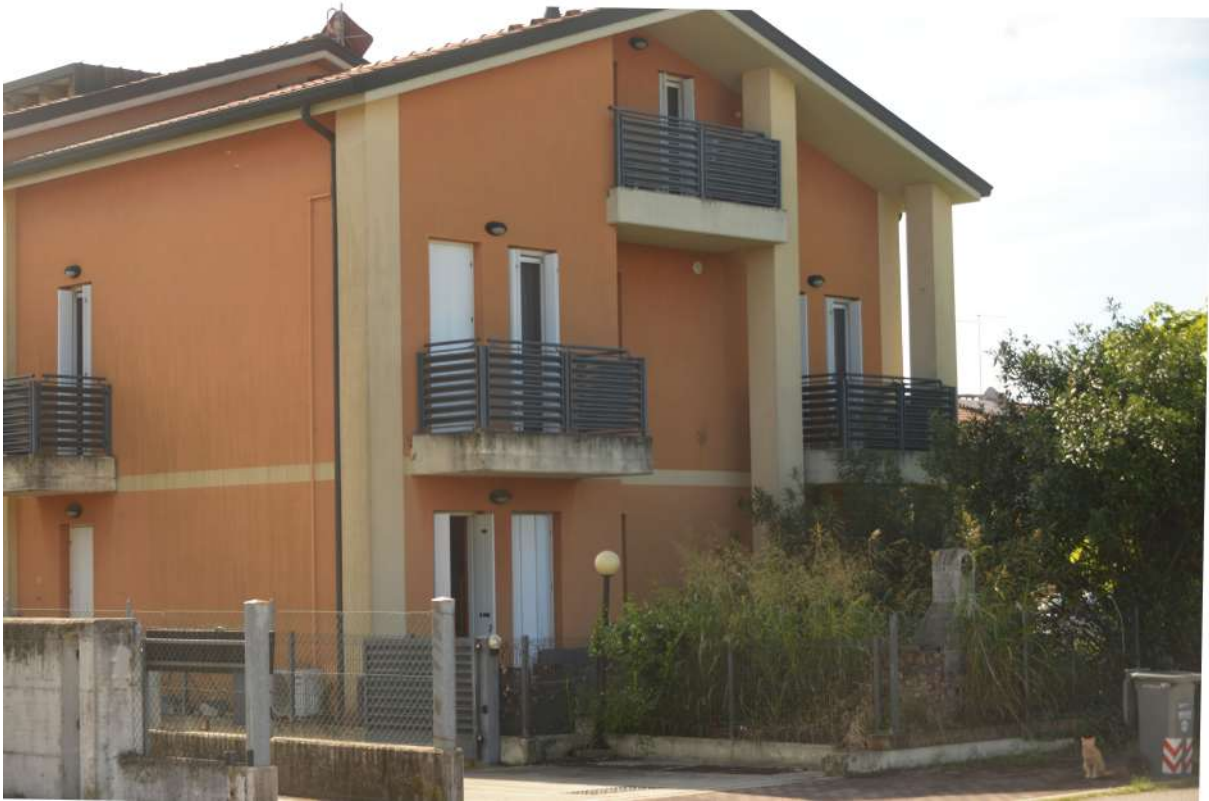
Foto n. 15 – Prospetto Nord - Ovest
