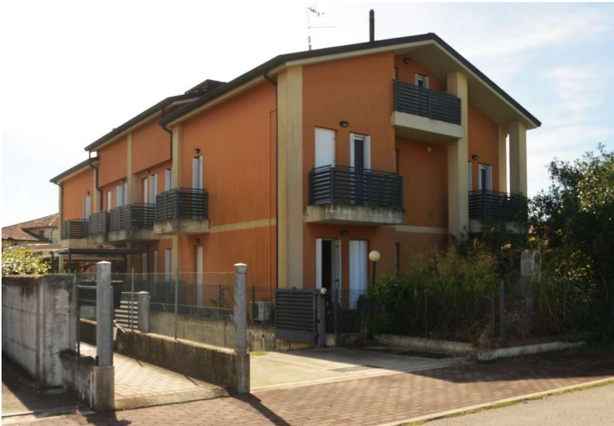
Foto n. 1- Prospetto Nord- Ovest fabbricato su Via Mons. E. Bacchion
