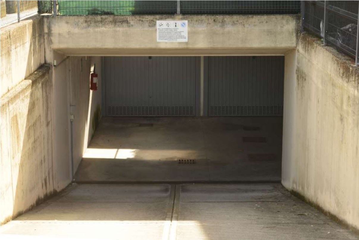
Foto n. 28 – Rampa d'accesso autorimesse
