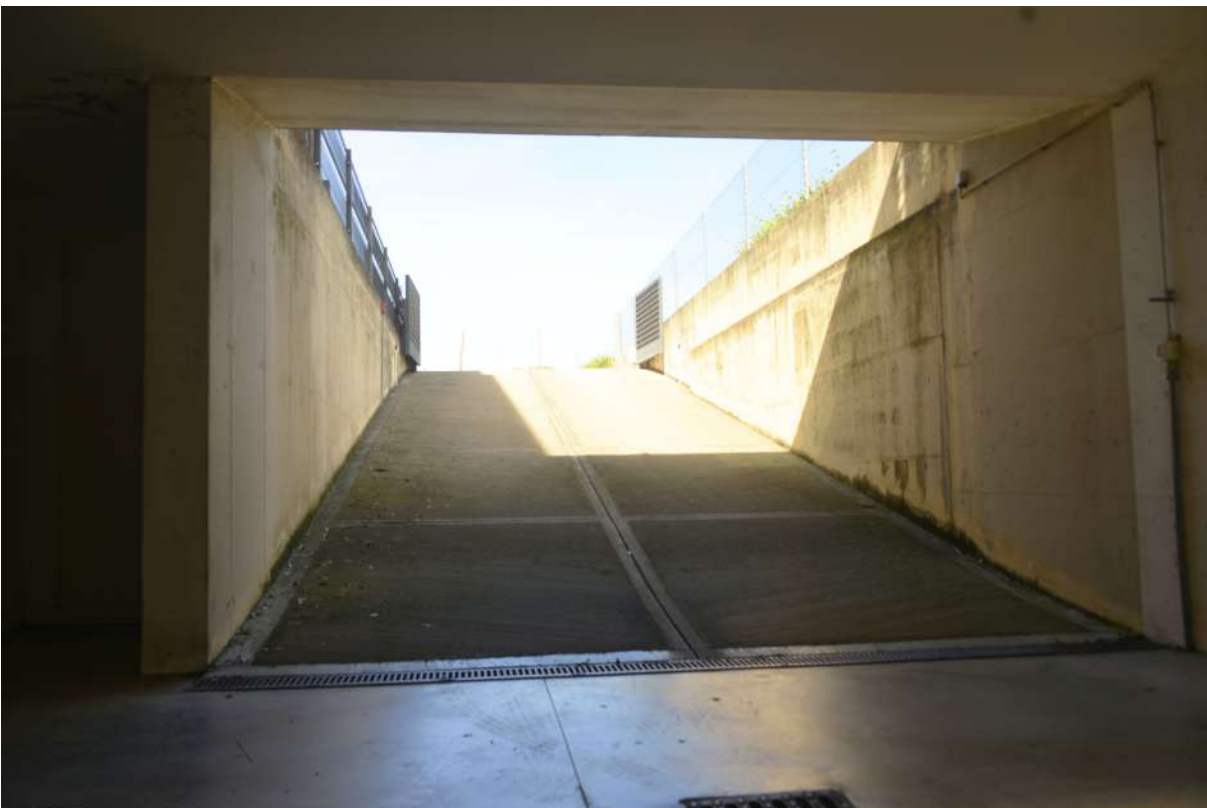
Foto n. 29 rampa d'accesso autorimesse
