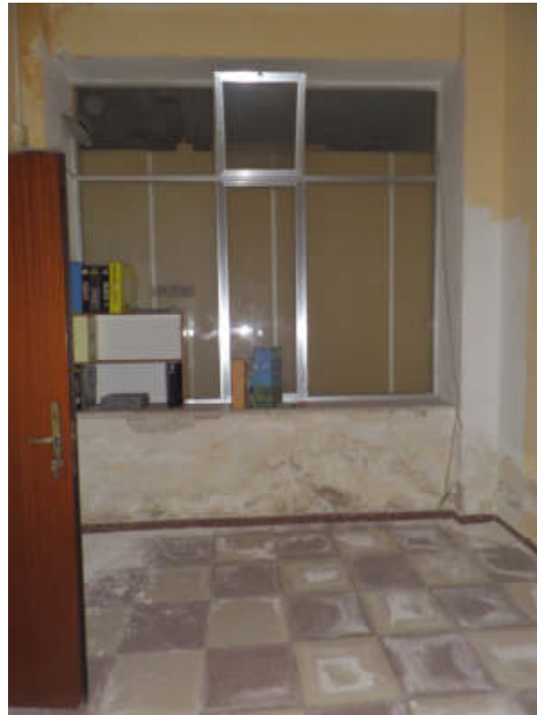
Foto n° T.8. P. T. Vano 1
