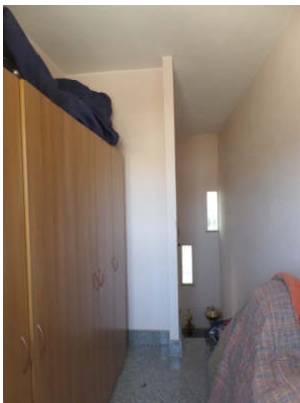
Foto n° V.4. Vano Scala: P. 3°
