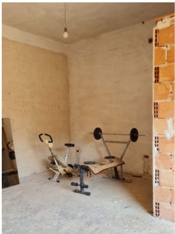
Foto n° A.3. P. T. Garage: parte est
