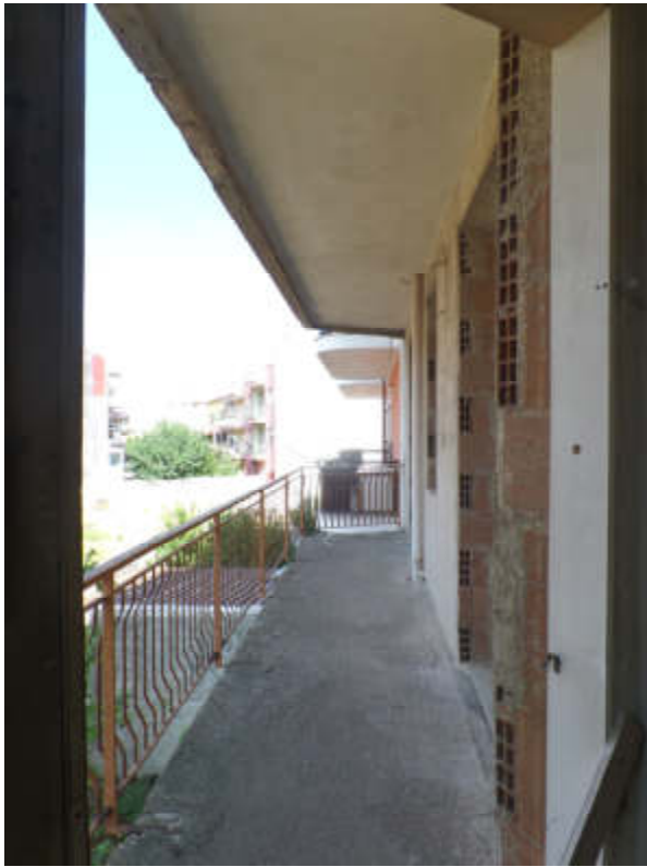
Foto n° B.7. P. 1°. Balcone su cortile interno
