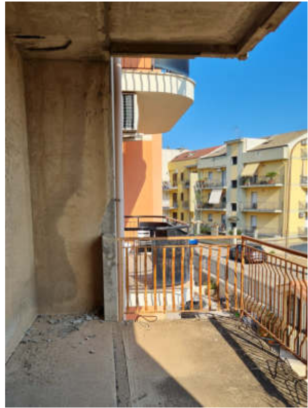
Foto n° B.8. P. 1°. Balcone su Via Panagulis
