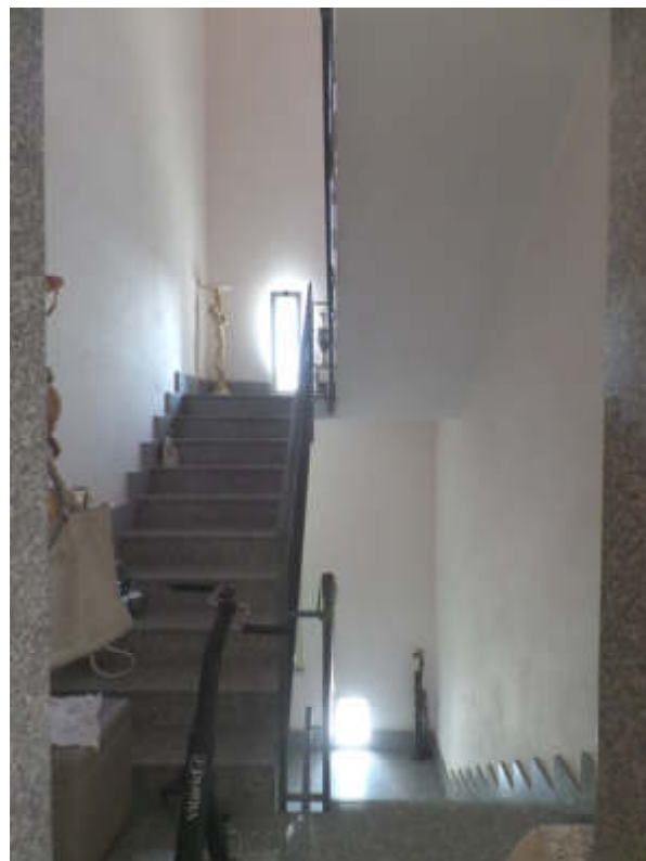
Foto n° V.2. Vano Scala: P. 2°
