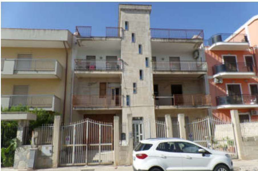
Foto n° 3. Via Alexandros Panagulis n° 11
