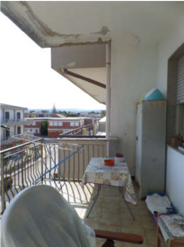
Foto n° C.9. P. 2°. Balcone su Via Panagulis
