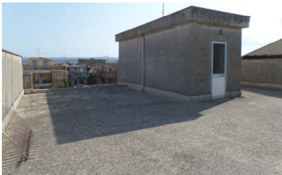
Foto n° Ter.3. P. 3° Terrazza
