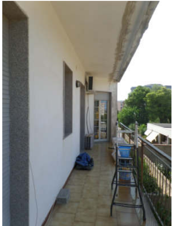
Foto n° C.10. P. 2°. Balcone su cortile interno
