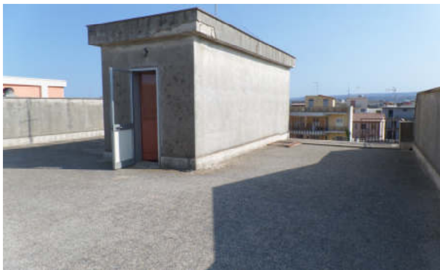
Foto n° Ter.2. P. 3° Terrazza
