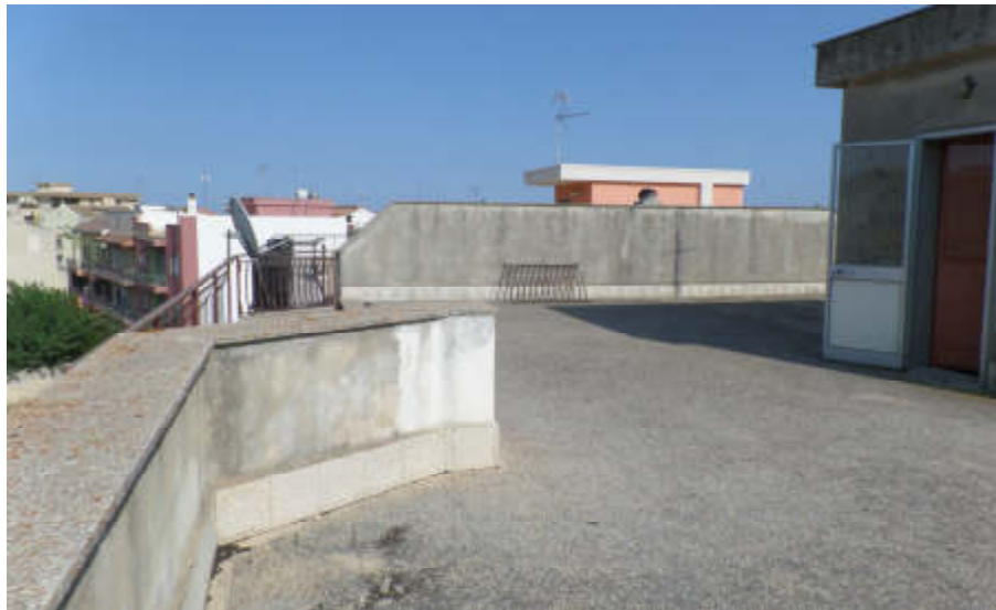
Foto n° Ter.1. P. 3° Terrazza
