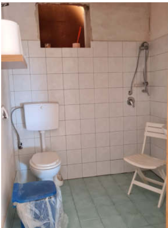
Foto n° A.4. P. T. Bagno
