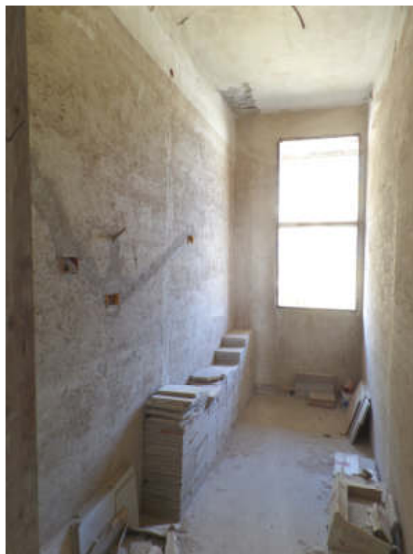
Foto n° B.6. P. 1°. Bagno 1
