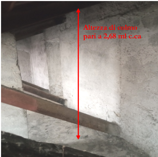
Foto n. 8 - Interni con misurazione dell'altezza di colmo
