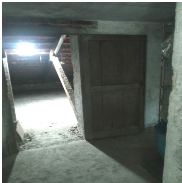
Foto n. 4 - Disimpegno con altezza di altezza di circa 2,15 ml
