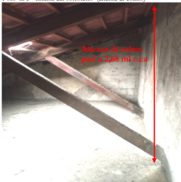
Foto n. 5 - Interni del sottotetto (altezza di colmo)
