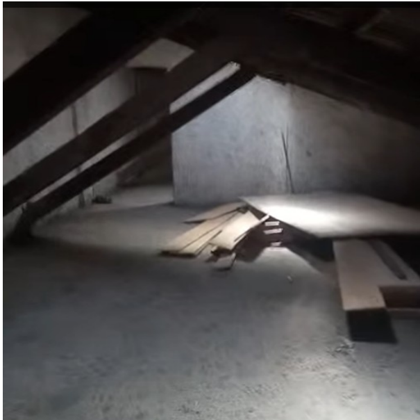
Foto n. 2 - Interni del sottotetto
