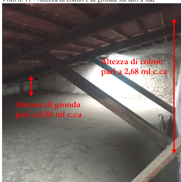
Foto n. 11 - Altezza di colmo e di gronda sul lato a sud
