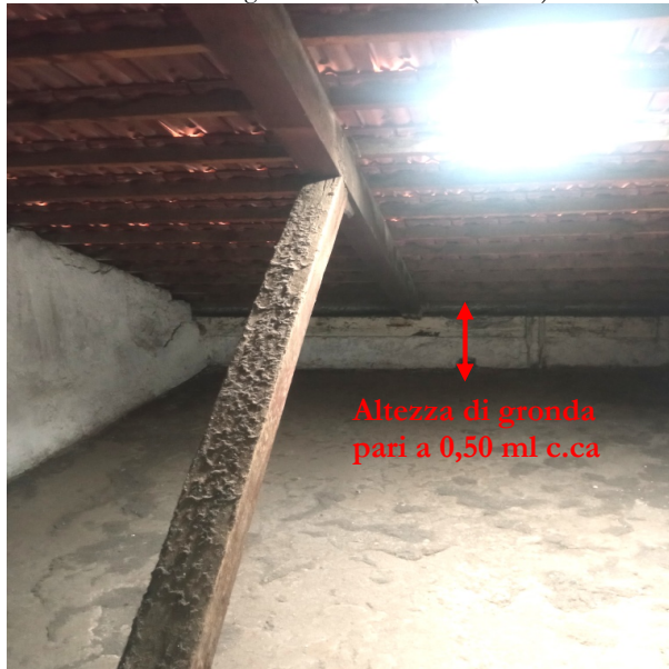
Foto n. 9 - Altezza di gronda sul lato ad est (cortile)
