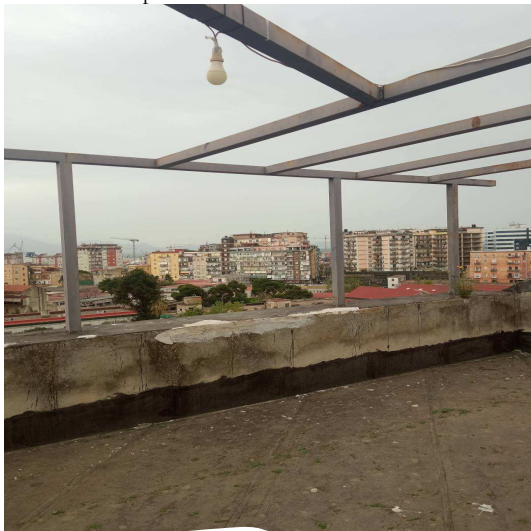
Foto n. 3 – Copertura del sottotetto rimossa
