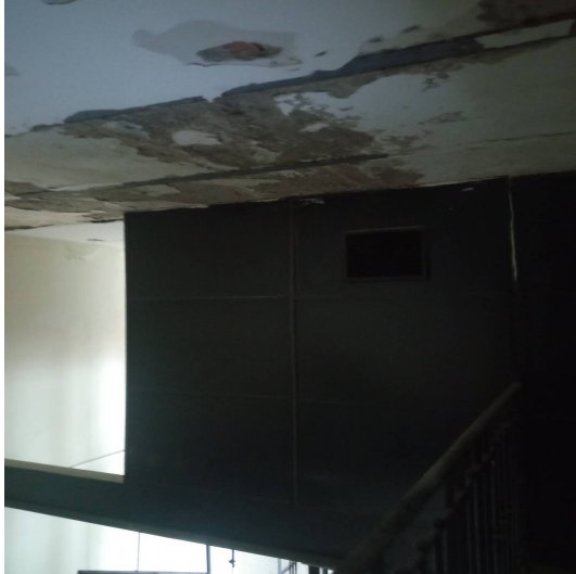
Foto n. 9 – Degrado del soffitto del vano scala
