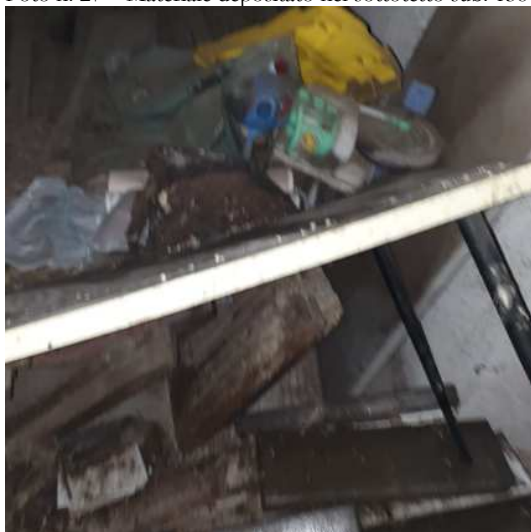
Foto n. 27 – Materiale depositato nel sottotetto sub. 138
