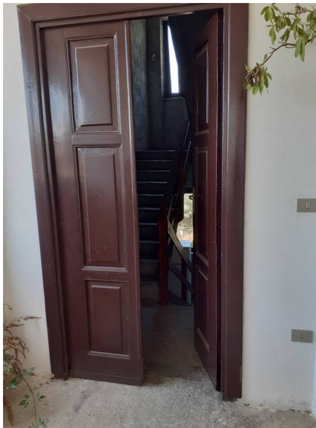
Foto n. 5 – Portoncino d'ingresso al vano scala
