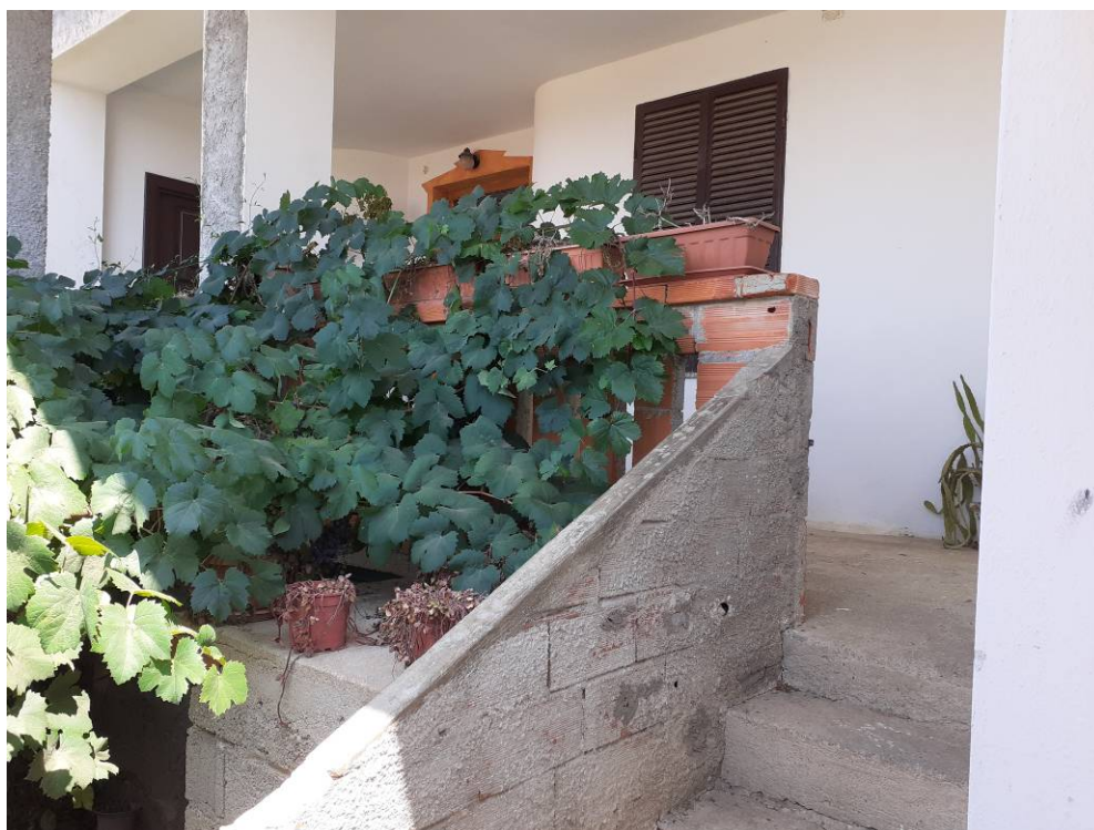
Foto n. 4 – Pianerottolo d'ingresso al vano scala
