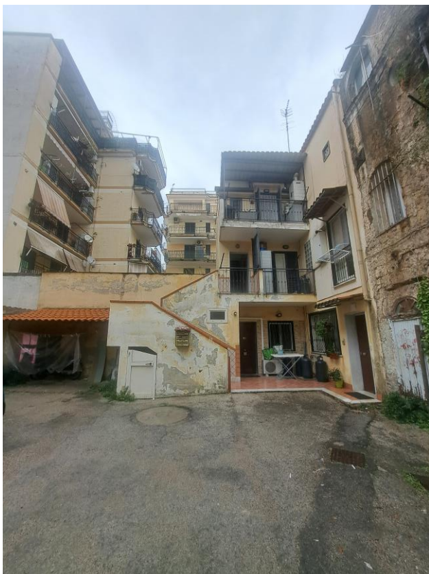
vista esterna del fabbricato ove è allocato l'immobile de quo
