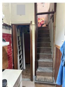
Foto n. 38 - Vano scala di accesso al terrazzo
