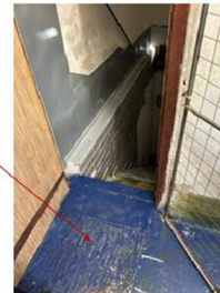
Foto n. 58 - Accesso al terrazzo attraverso porzione di terrazzo di proprietà aliena
