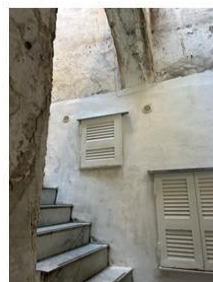
Foto n. 5 - Fabbricato - vano scala
