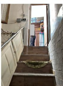
Foto n. 43 - Vano scala di accesso al terrazzo
