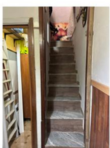
Foto n. 41 - Vano scala di accesso al terrazzo
