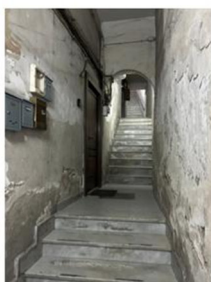
Foto n. 3 - Fabbricato - vano scala
