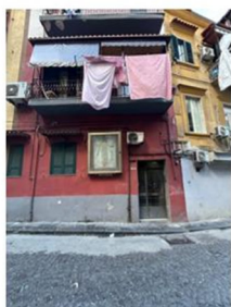
Foto n. 1 - Fabbricato in cui è ubicato l'immobile pignorato
