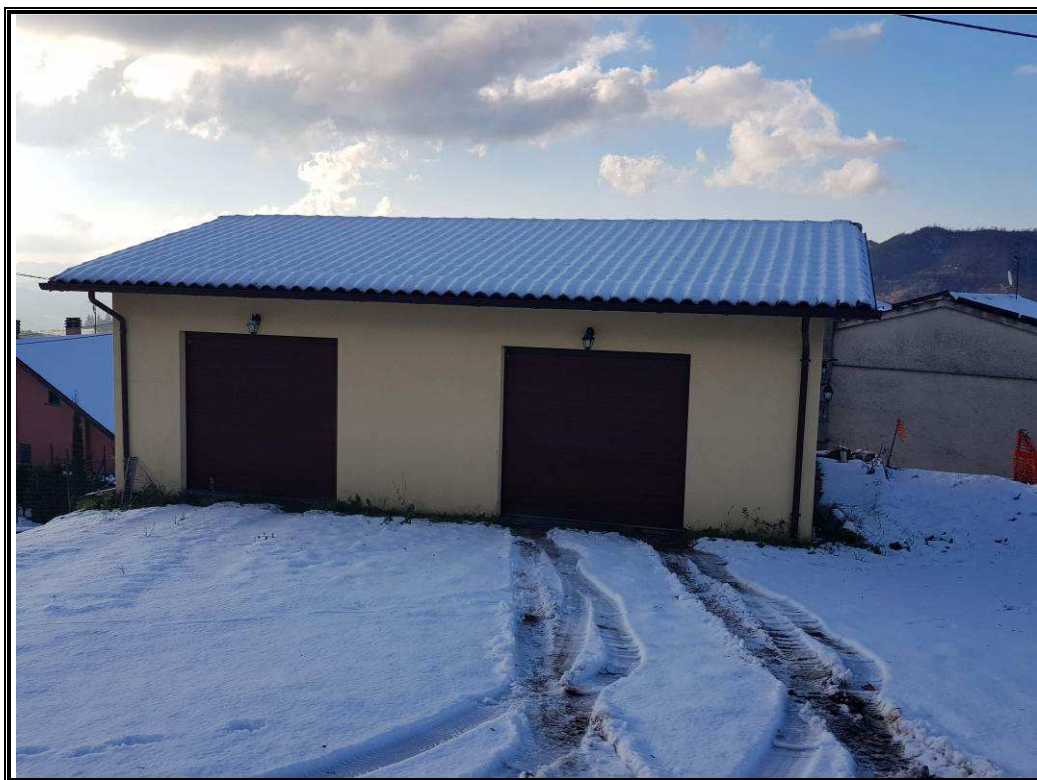
Foto n. 23 Vista esterna del fabbricato adibito a garage e fondo.
