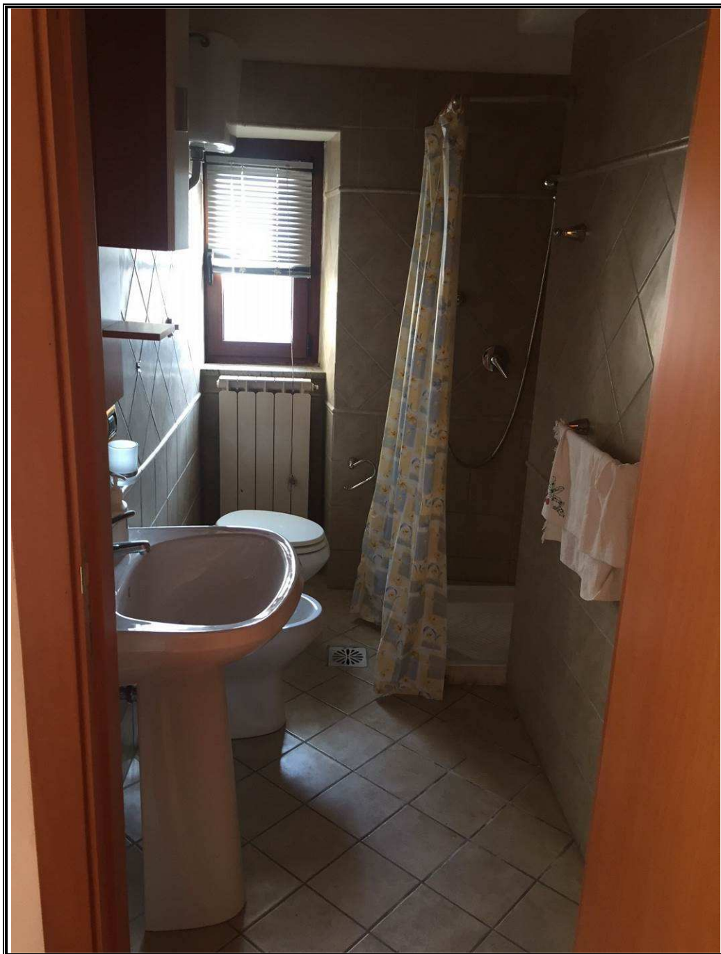
Foto n. 12 Bagno a servizio del locale del piano terra per il quale è stato realizzato abusivamente il cambio d'uso.
