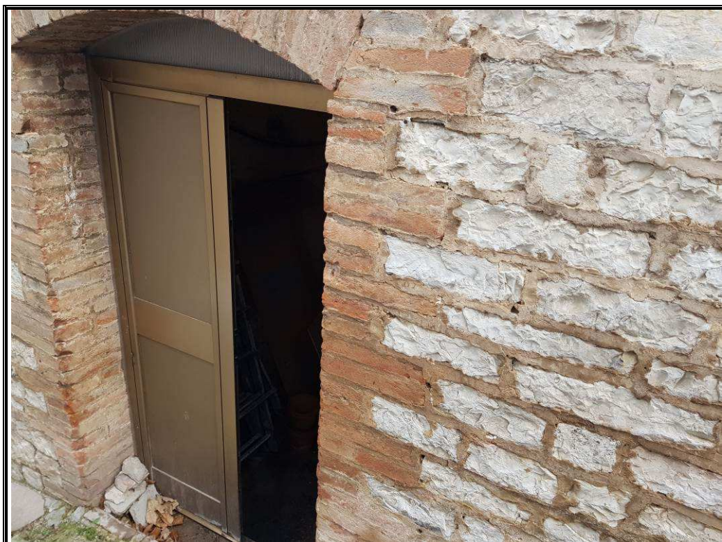
Foto n. 5 Ingresso al locale fondo del piano terra ubicato sul versante di monte.
