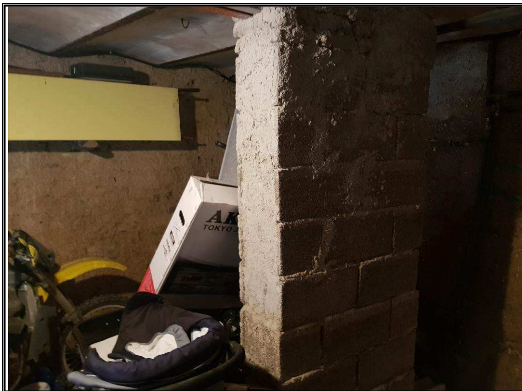
Foto n. 7 Locale fondo del piano terra ubicato sul versante di monte.
