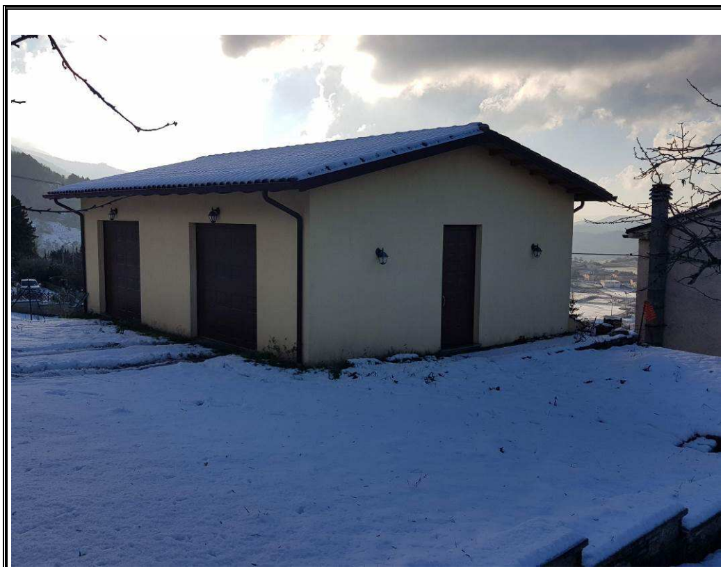
Foto n. 24 Vista esterna del fabbricato adibito a garage e fondo.
