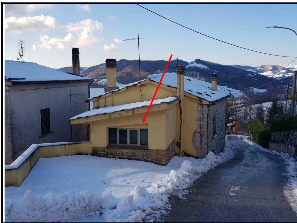
Foto n. 1 Vista del fabbricato abitativo con, in primo piano, il manufatto abusivo da demolire.
