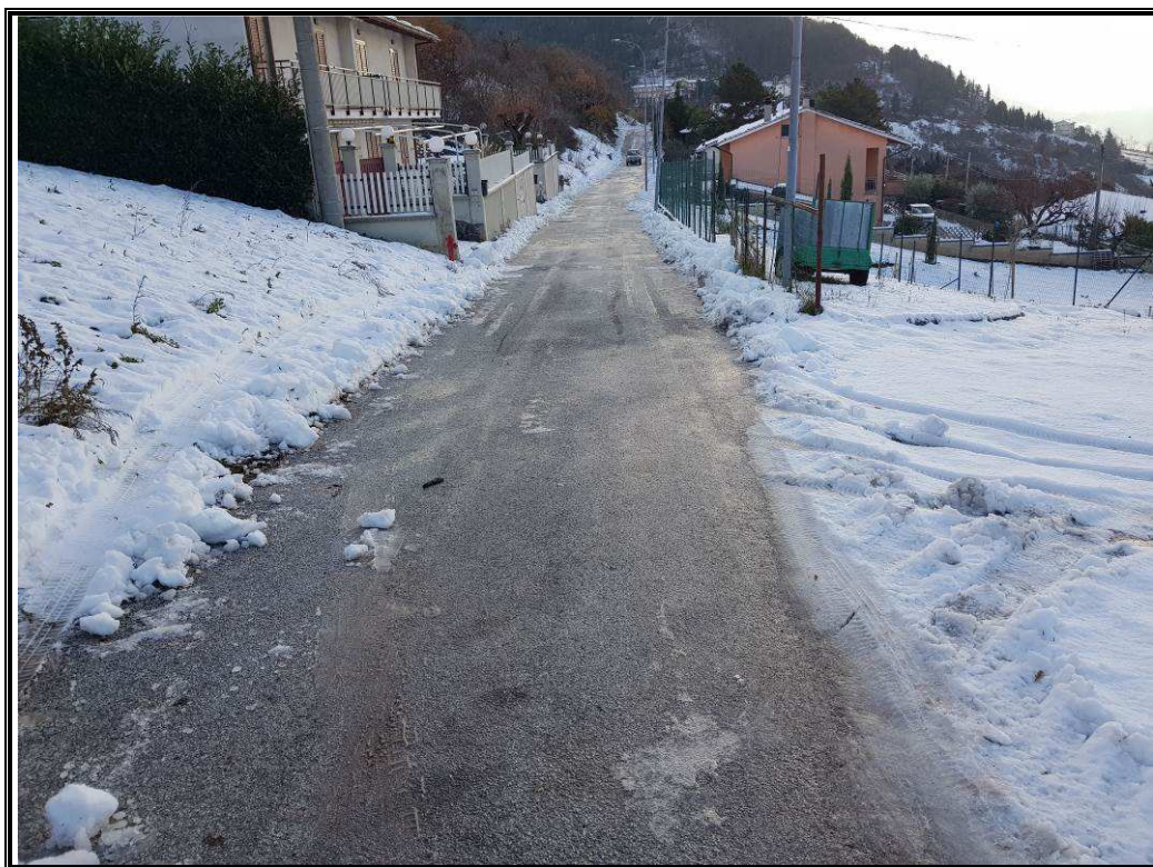
Foto n. 25 Vista della sede stradale di via Martiri della Resistenza.
