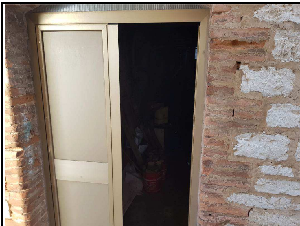
Foto n. 8 Ingresso al locale fondo del piano terra, adiacente a quello ubicato sul versante di monte.
