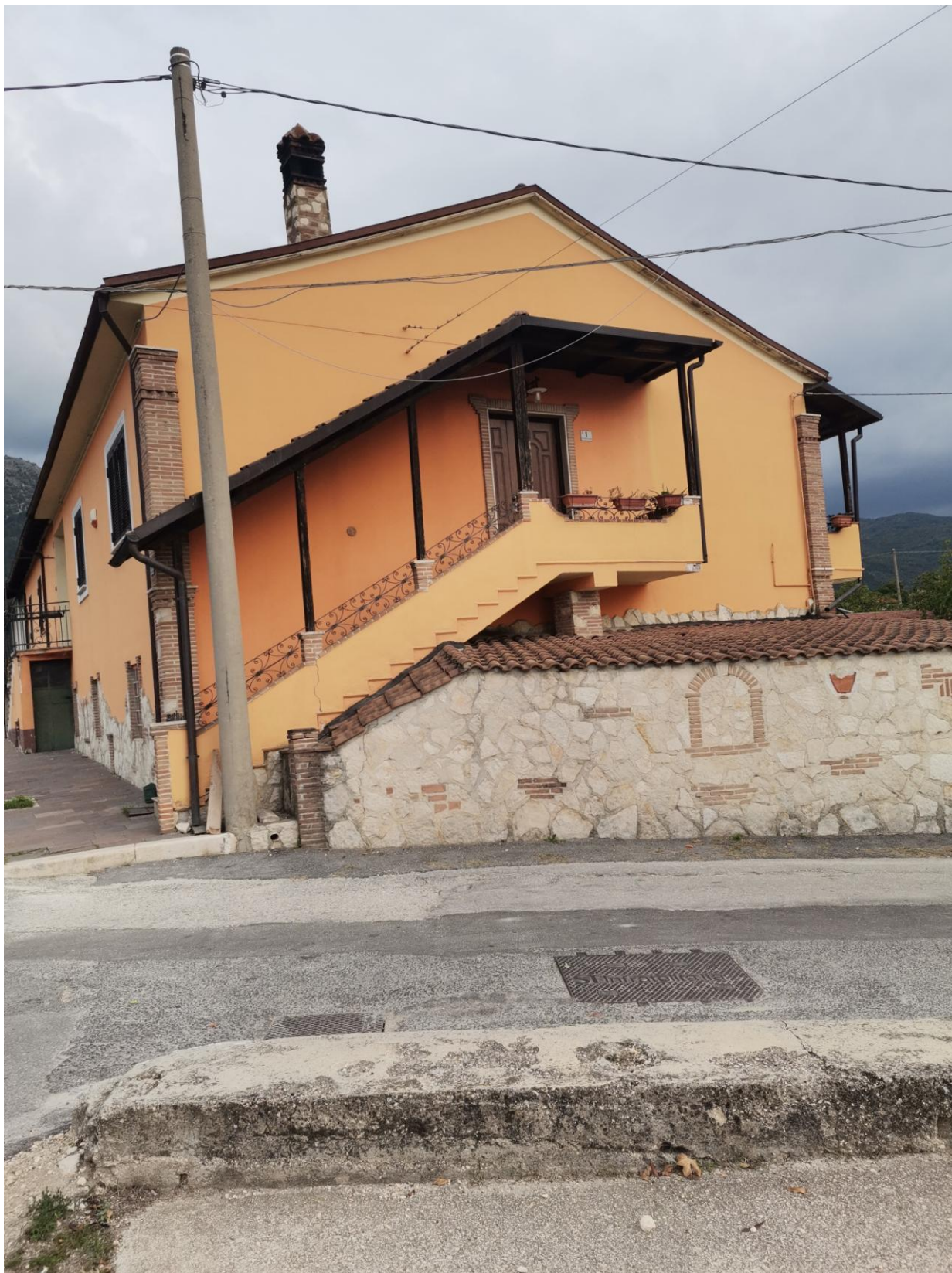
Ingresso laterale, scala esterna
