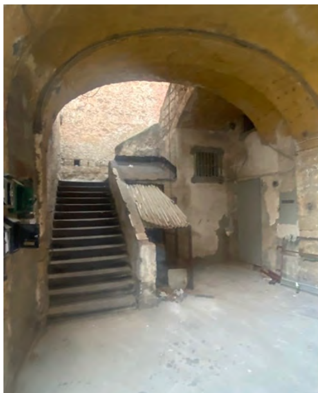
Foto F_ Vista della scala aperta per l'accesso al ballatoio comune
