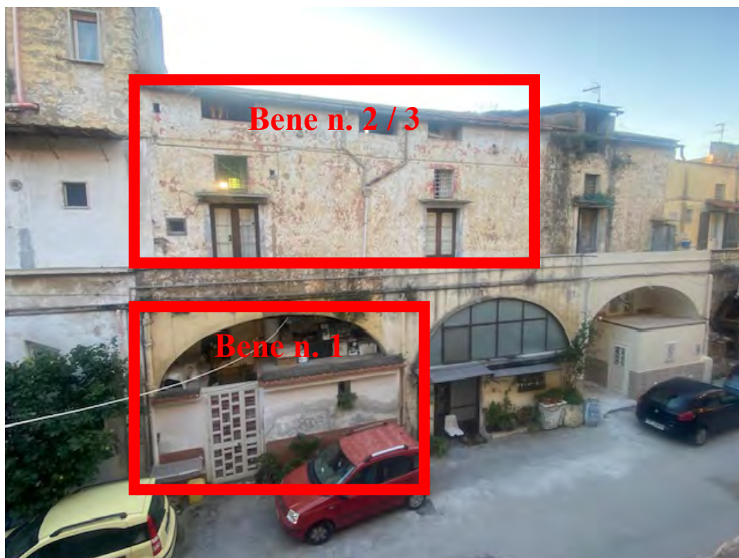
Foto E_ Vista del fronte est con indicazione beni
