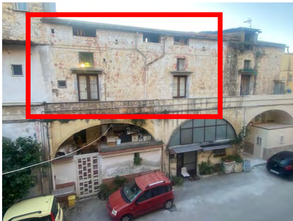
Foto 7_ Vista degli ingressi dal ballatoio comune con affaccio sulla corte centrale
