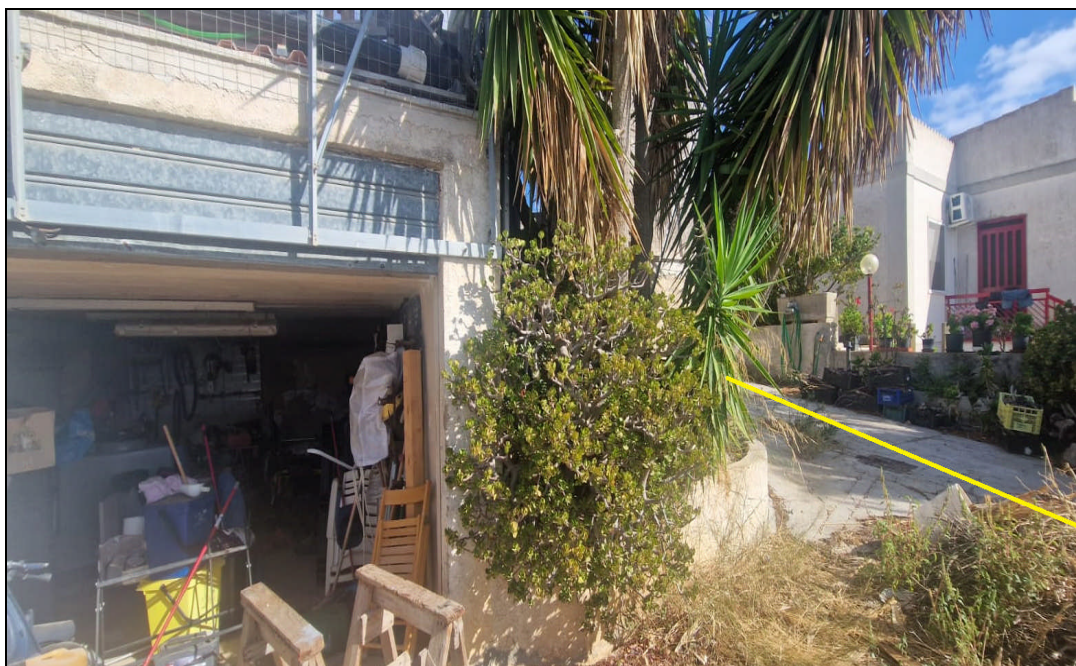
Foto 15: Particolare ingresso “locale Garage” (piano Seminterrato)
