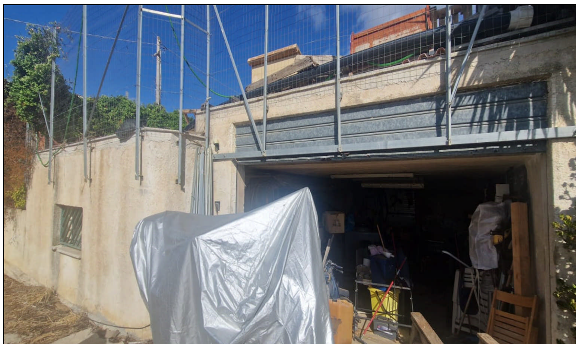
Foto 14: Particolare ingresso “locale Garage” (piano Seminterrato)
