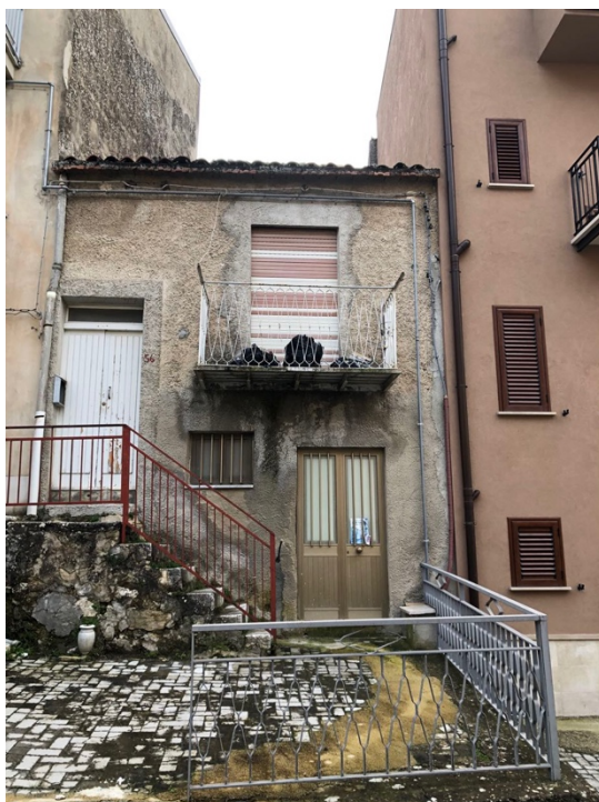
Foto esterna su via Valle n. 46 n. 48
