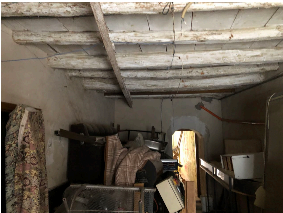
Particolare solaio stanza 1 piano terra
