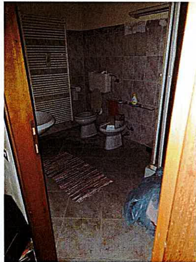
Bagno Piano Primo
