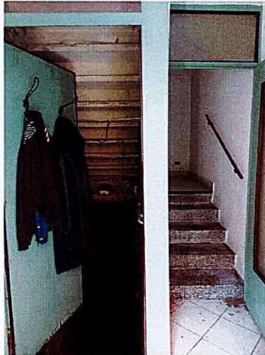
Ingresso scala Piano Terra
