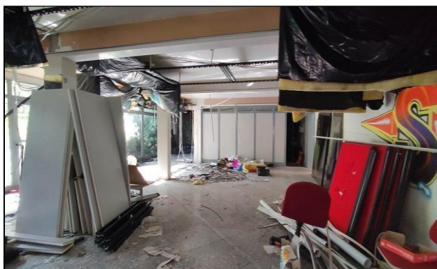
Vista interna degli uffici piano terra
