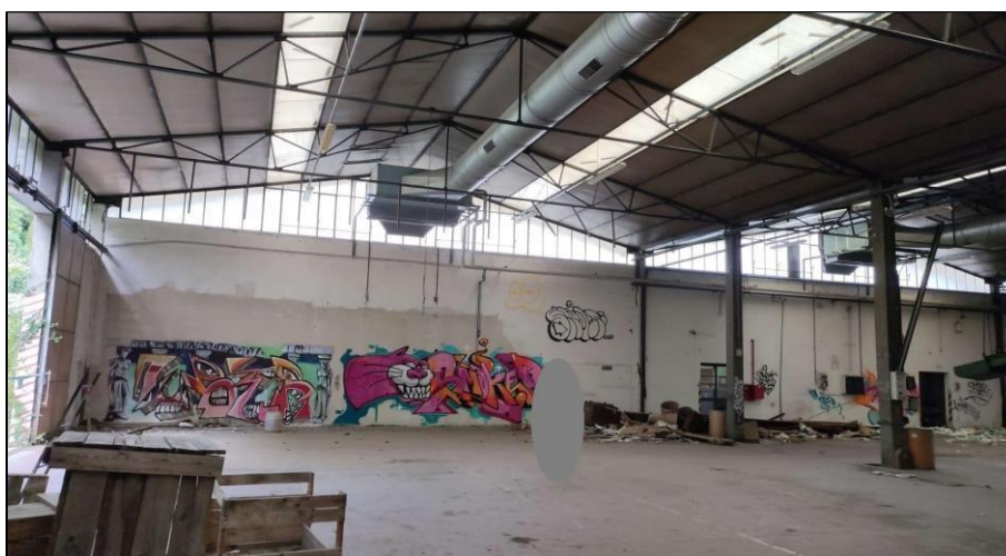
Vista interna capannone
