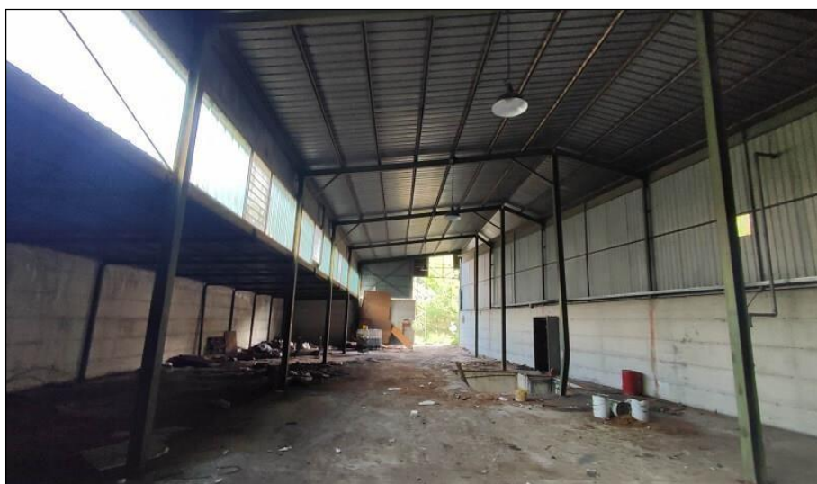
Vista interna parte principale dell'immobile F
