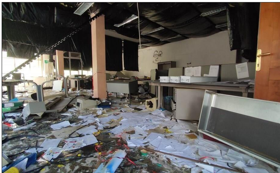
Vista interna degli uffici piano primo
