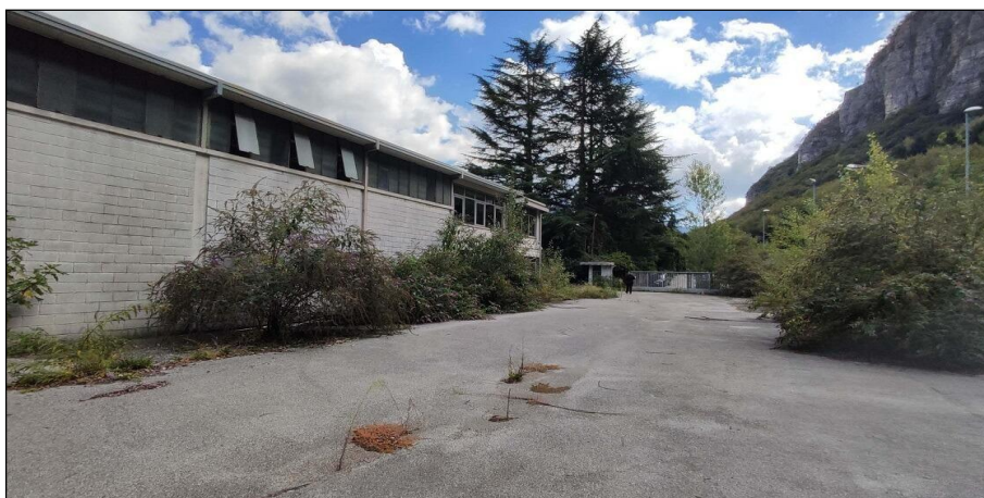
Vista facciata lato ovest
