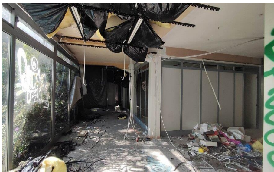
Vista interna degli uffici piano terra
