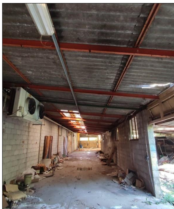
Vista immobile D – officina
