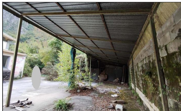
Tettoia confine nord-ovest
