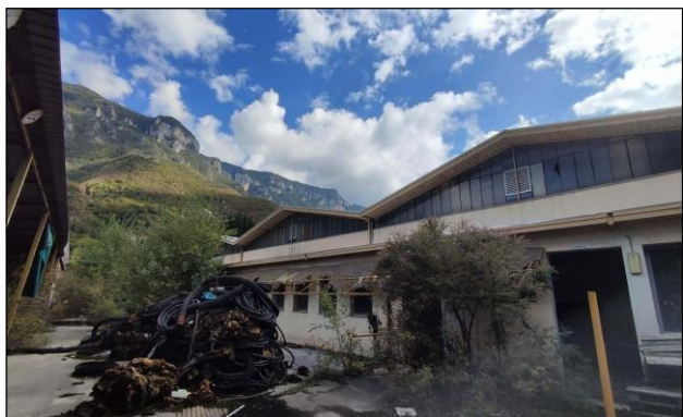
Vista lato nord
