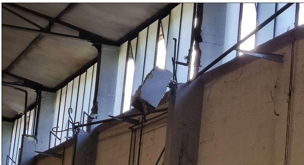
Pari dei pilastri demoliti per asportazione carroponete
