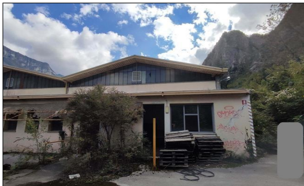
Vista lato nord
