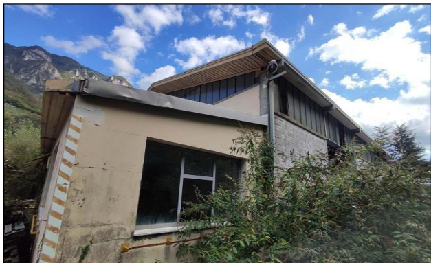
Vista angolo nord-ovest
