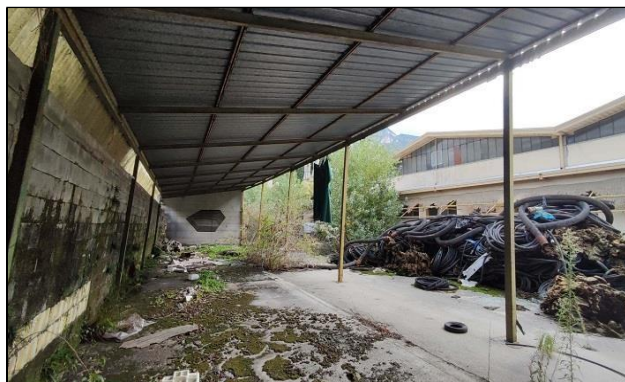
Tettoia confine nord-ovest
