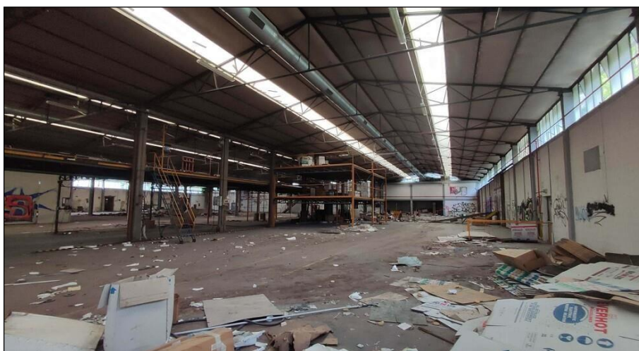
Vista interna capannone - soppalco
