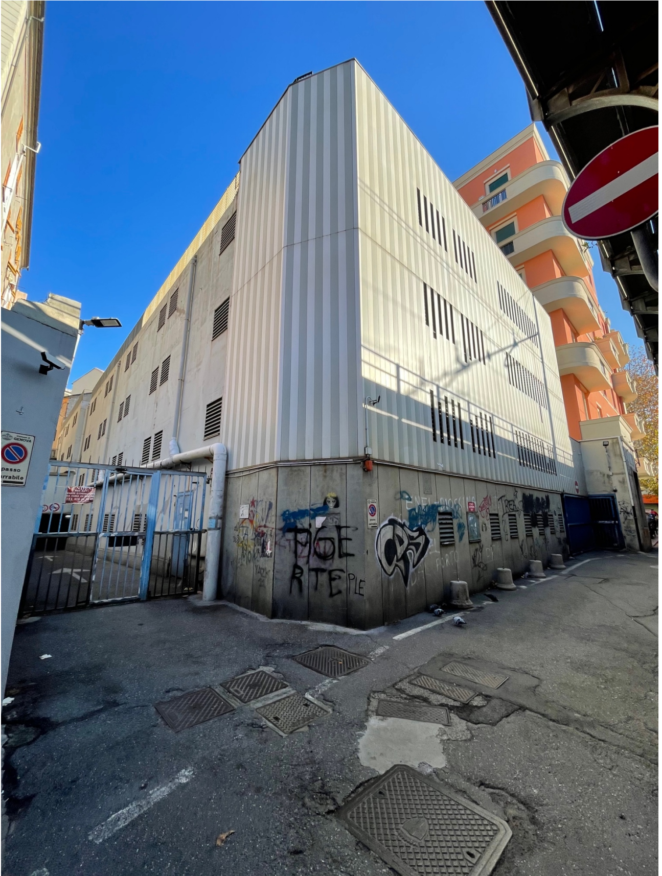
CIVICO 8 DI VIA ORSOLINO ADIBITO AD AUTOPARCHEGGIO
