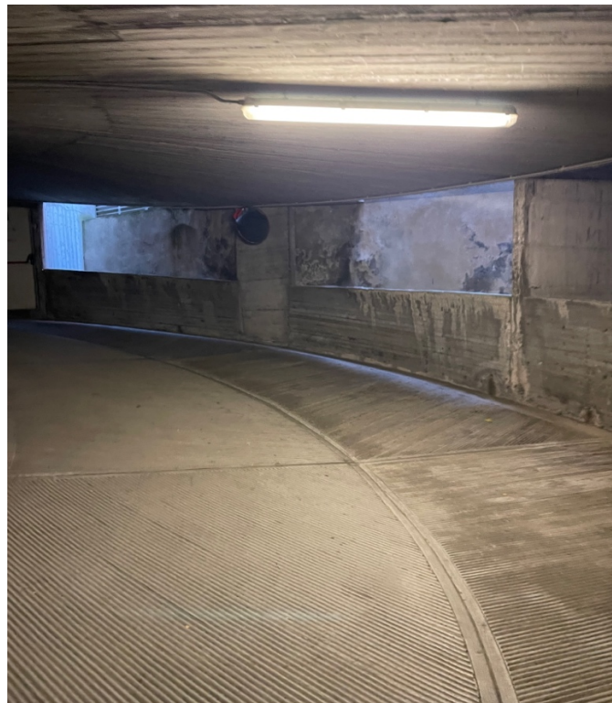
RAMPE DI ACCESSO AL TERZO PIANO
