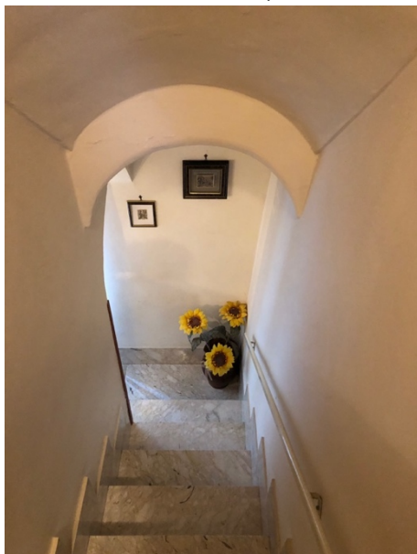
Particolare vano scala piano terra
