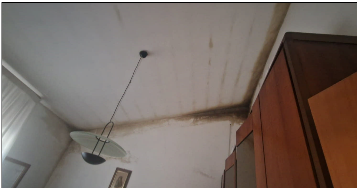
Foto 11: Particolare interno stato conservativo solaio di copertura
