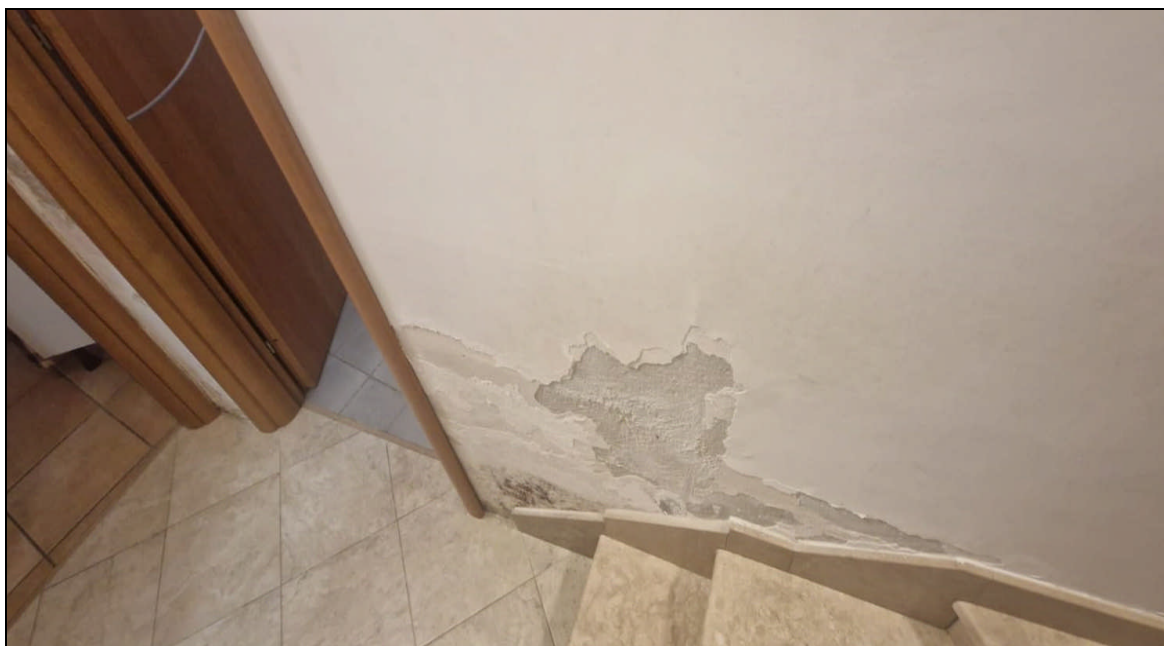
Foto 12: Particolare interno stato di conservativo delle pareti
