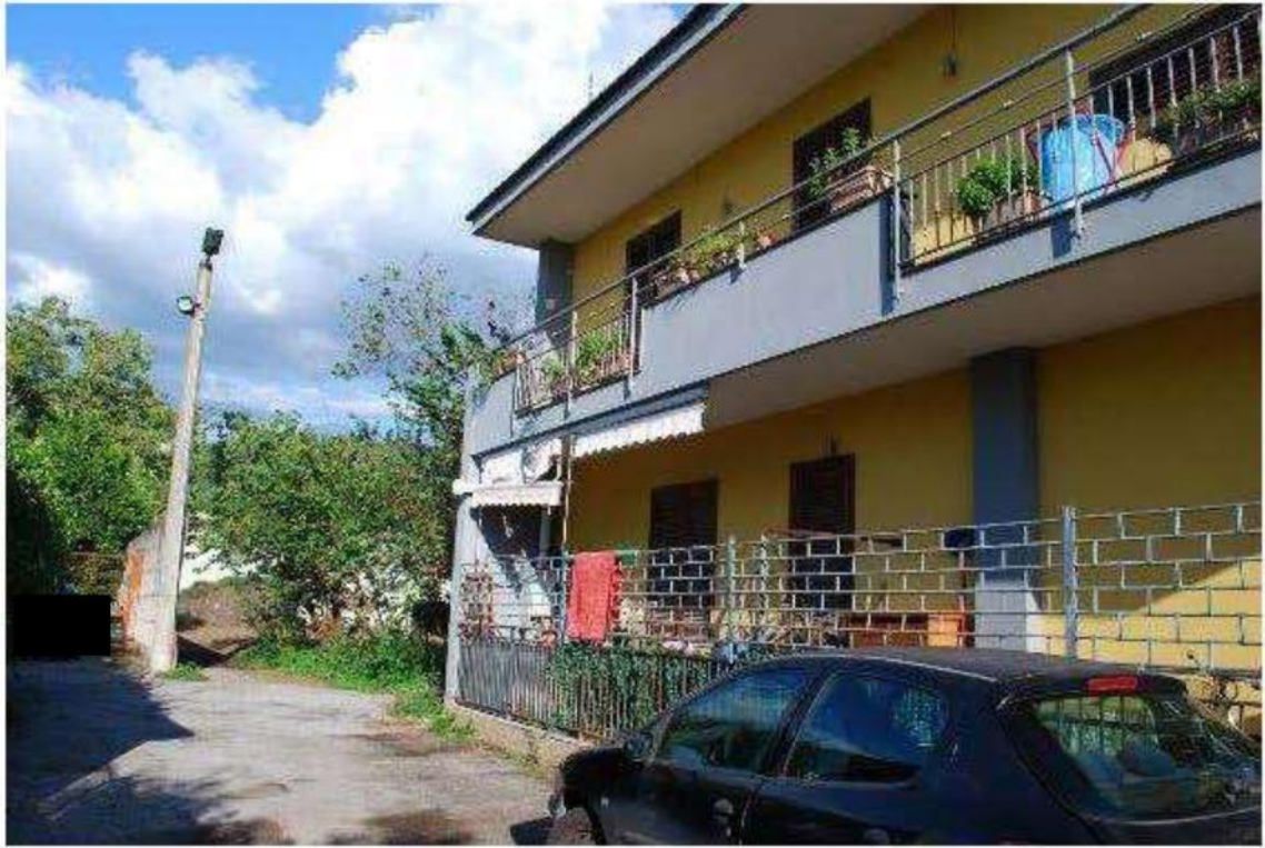
Foto n. 3 – LOTTO 1-PT-facciata nord-ovest
