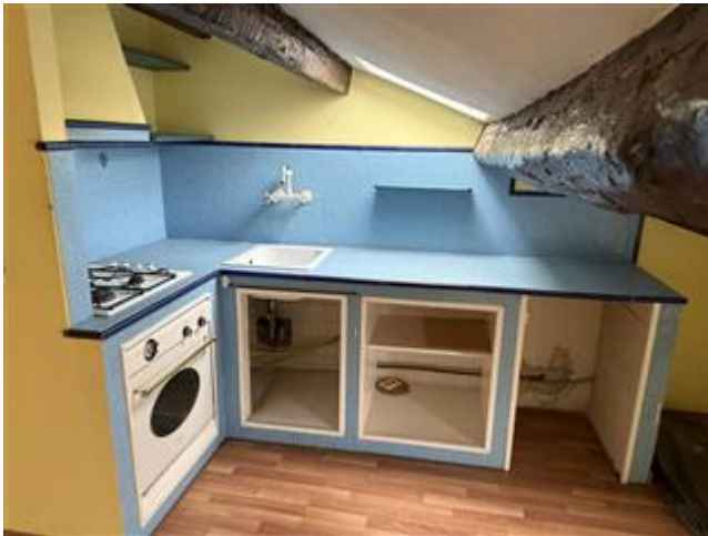
Cucina in muratura
