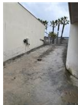
Rampa di accesso dal Lungomare
