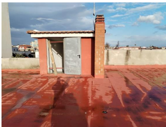
Foto n°16- Vista del terrazzo di copertura
