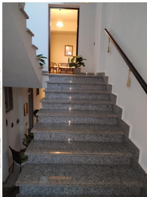
Foto n°10- Vista della scala di accesso al P.1
