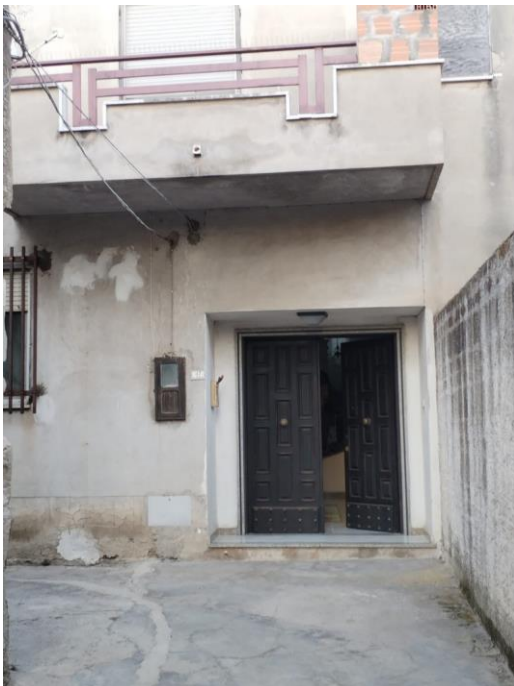
Foto n°1- Vista dell'ingresso pedonale del fabbricato
