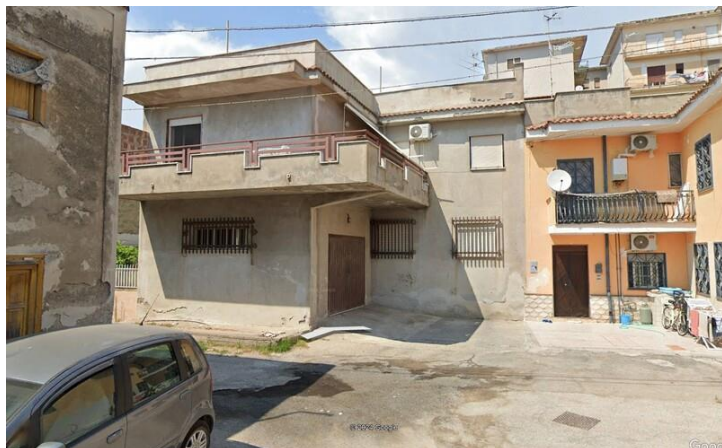
Foto n°9- Vista del prospetto sud e est del fabbricato
