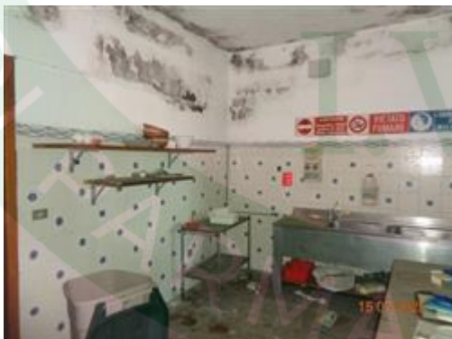
Foto - Piano terra - Cucina
