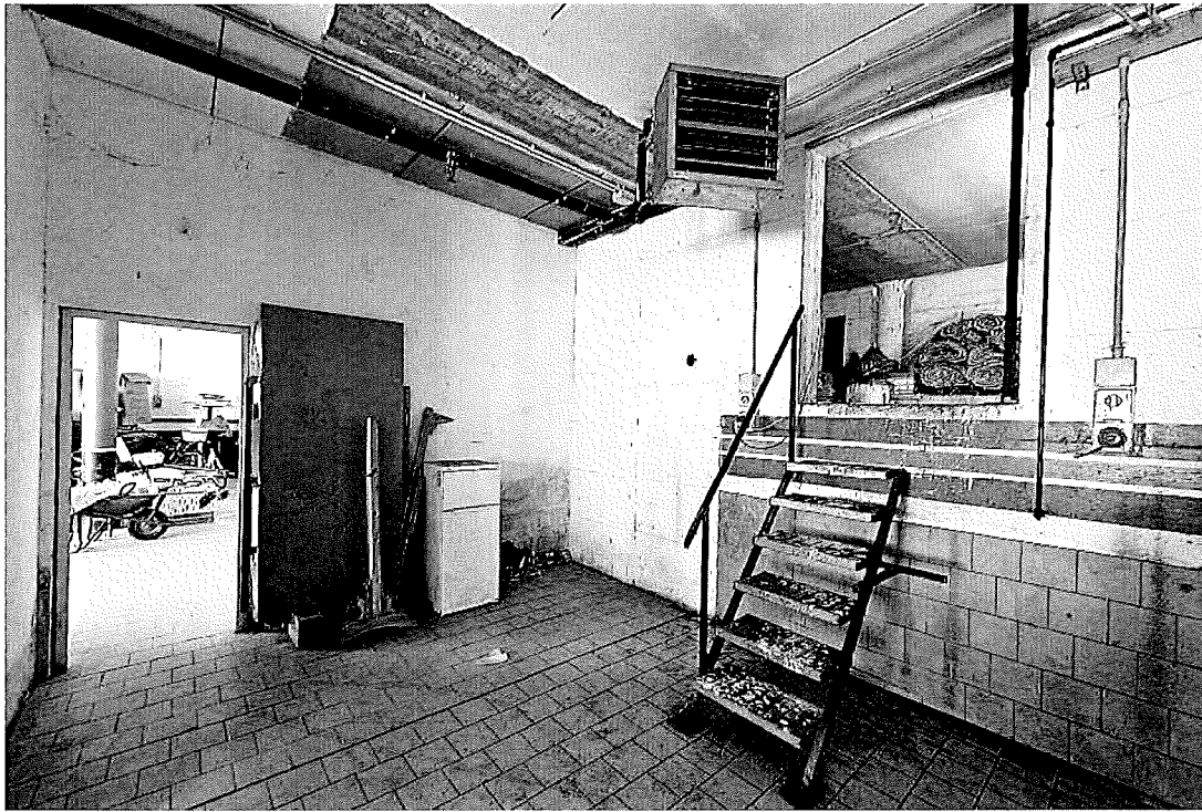
Accesso al vespaio areato
