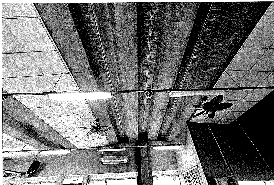
Soffitti in c.a. prefabbricato - ribassamenti e impianto luci
