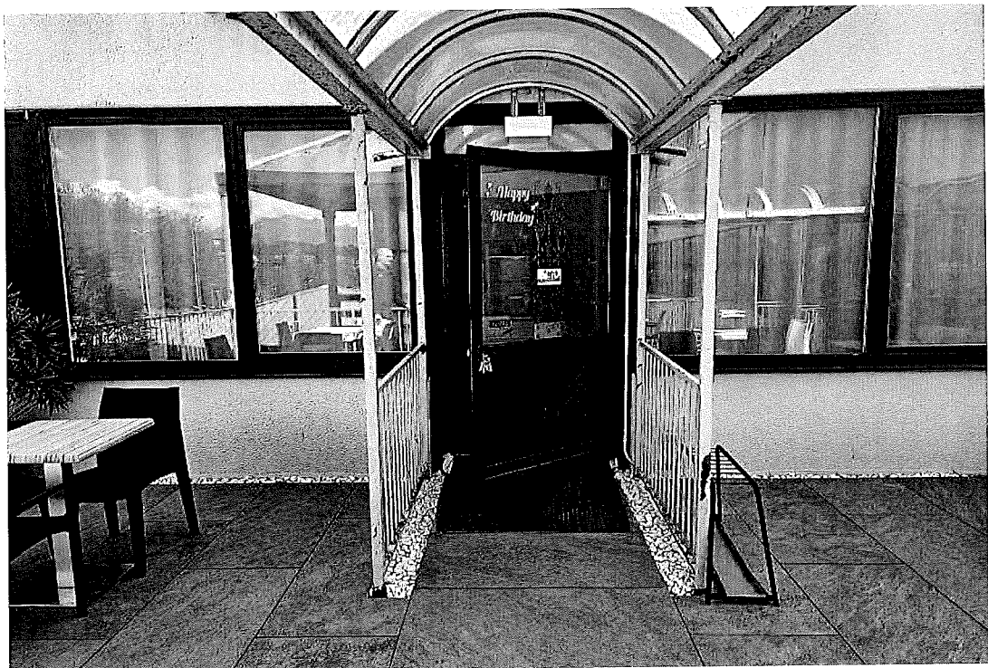
Ingresso al Lotto 003
