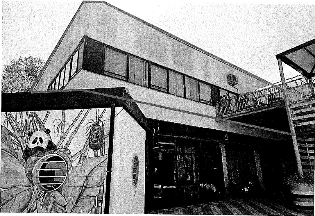
Visione esterna da piano terra del Lotto 003
