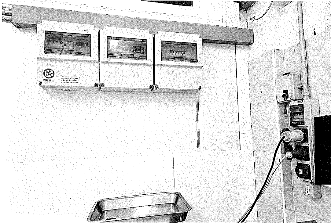
Ulteriori quadri elettrici nella zona di lavorazione
