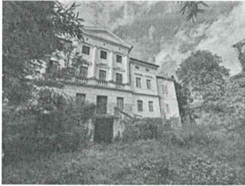
Edificio condominiale, Fronte
