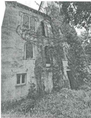
Edificio condominiale, Retro
