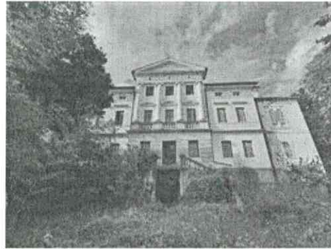
Edificio condominiale, Fronte
