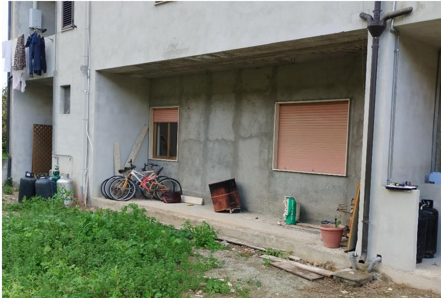
Fig. 3: superfetazioni – vista fotografica dal terreno adiacente
