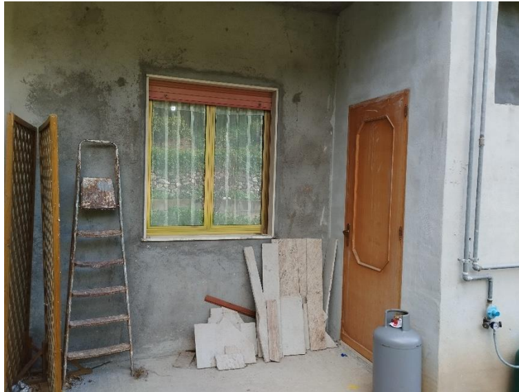
Foto 6, le finestre esterne dell'appartamento staggito verso il cortile in particella 1039
