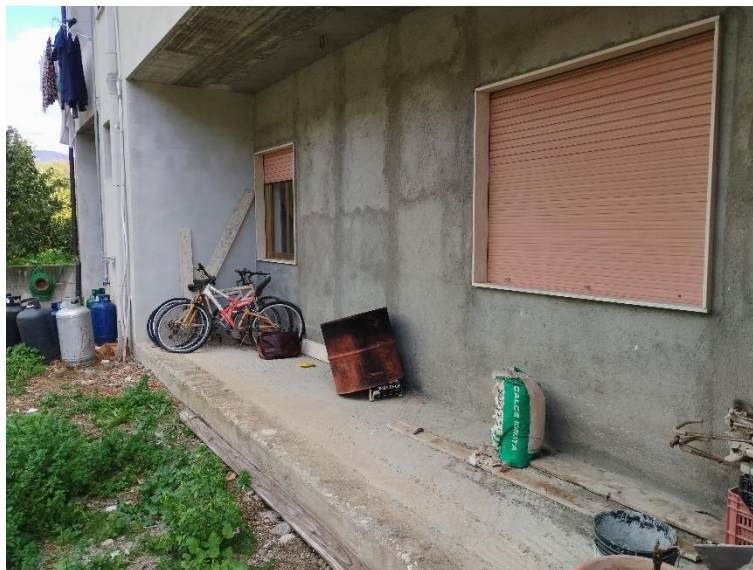
Foto 7, le finestre esterne dell'appartamento staggito verso il cortile in particella 1039
