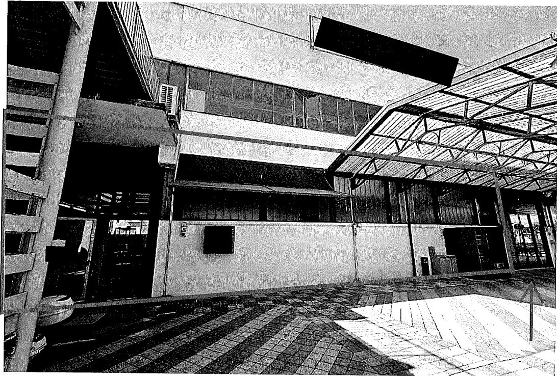
Esterno del Lotto 001 con indicazione dell'ingresso dal sub. 527
