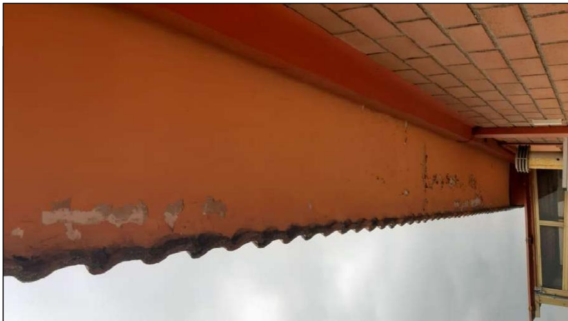
foto 23 - vista delle infiltrazioni dalla copertina esterna.
