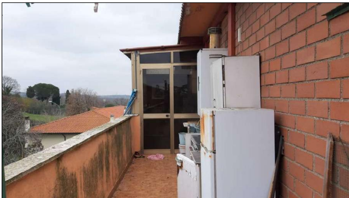
foto 20 - vista della veranda dall'esterno.
