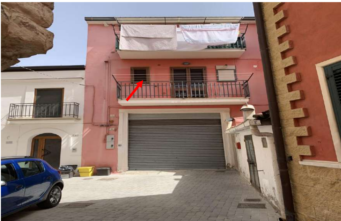
Prospetto principale – vista d'insieme del fabbricato
