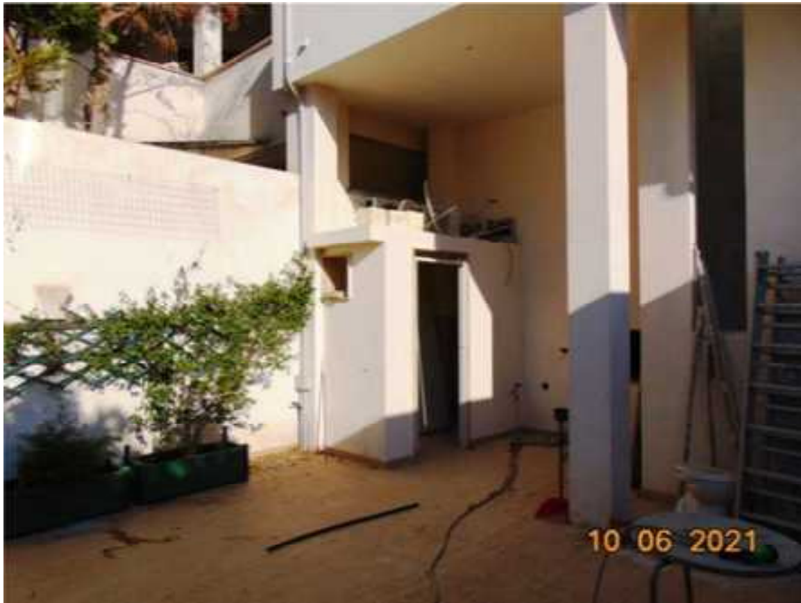
Foto n.36 – Veranda (retrostante abitazione)
