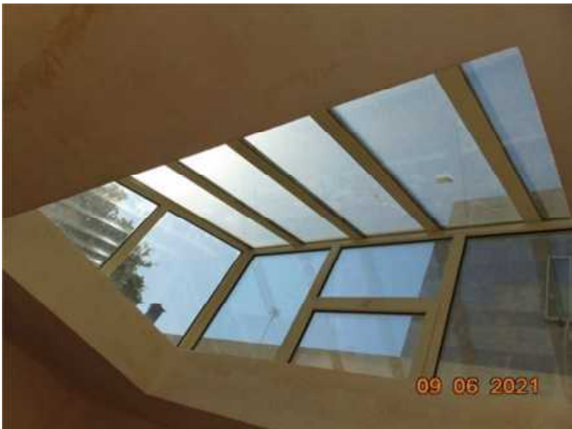
Foto n.35 – Lucernario su portico
