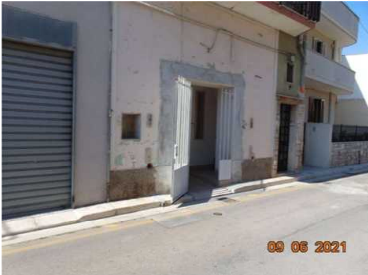
Foto n.3 – Prospetto fronte via Dottore Emanuele Cavaliere civico 19
