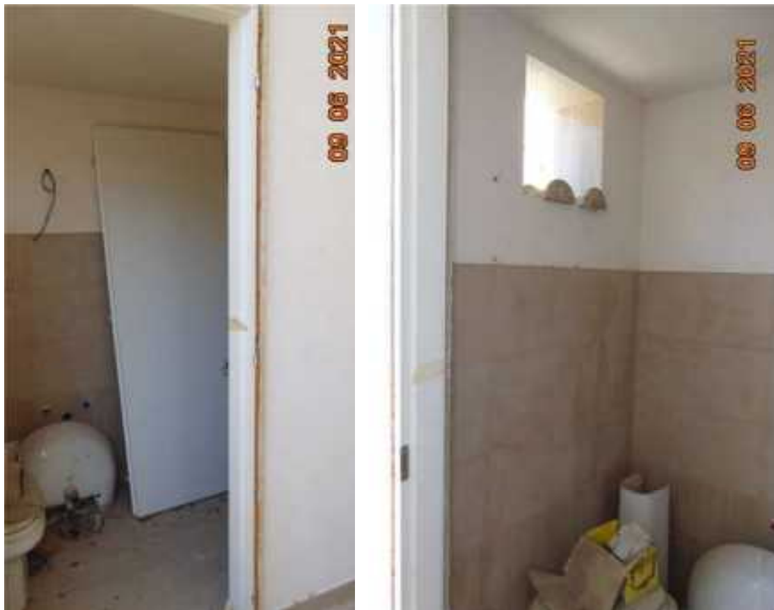
Foto nn.37 e 38 – Bagno (veranda)
