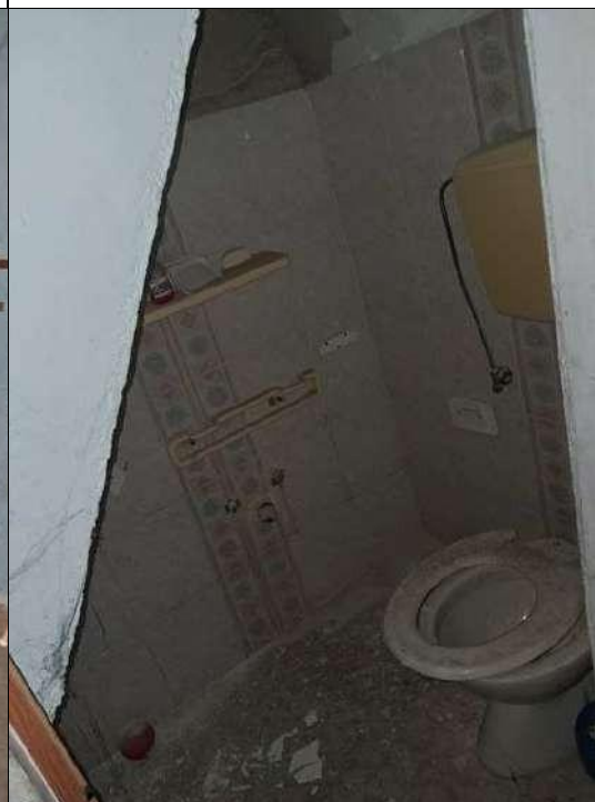
▲ Vista wc sottoscala
