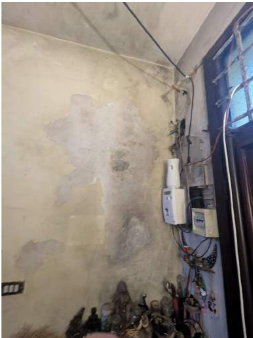
Procedura Esecutiva Immobiliare n.177/2024 - Documentazione Fotografica - VISTE INTERNE UNITA' ABITATIVA SUB.4 - PARTICOLARI
