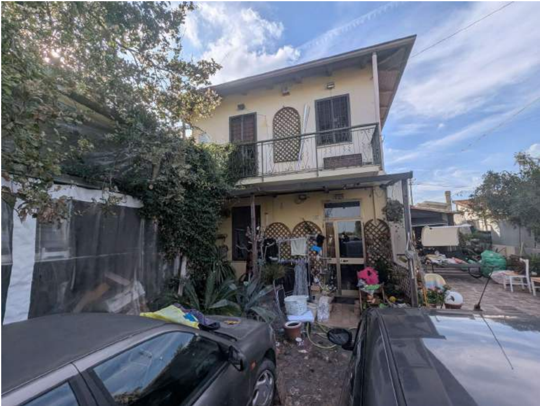
Procedura Esecutiva Immobiliare n.177/2024 - Documentazione Fotografica - VISTE ESTERNE UNITA' ABITATIVA SUB.4
