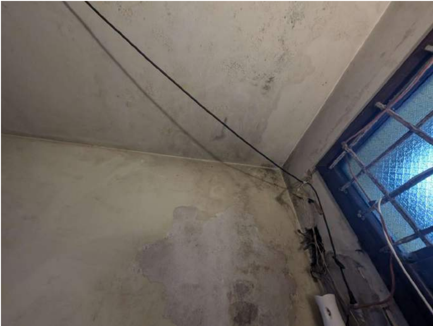
Procedura Esecutiva Immobiliare n.177/2024 - Documentazione Fotografica - VISTE INTERNE UNITA' ABITATIVA SUB.4 - PARTICOLARI
