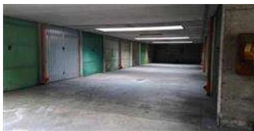
corsello di manovra
