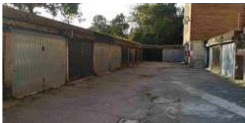
vista corsello box
