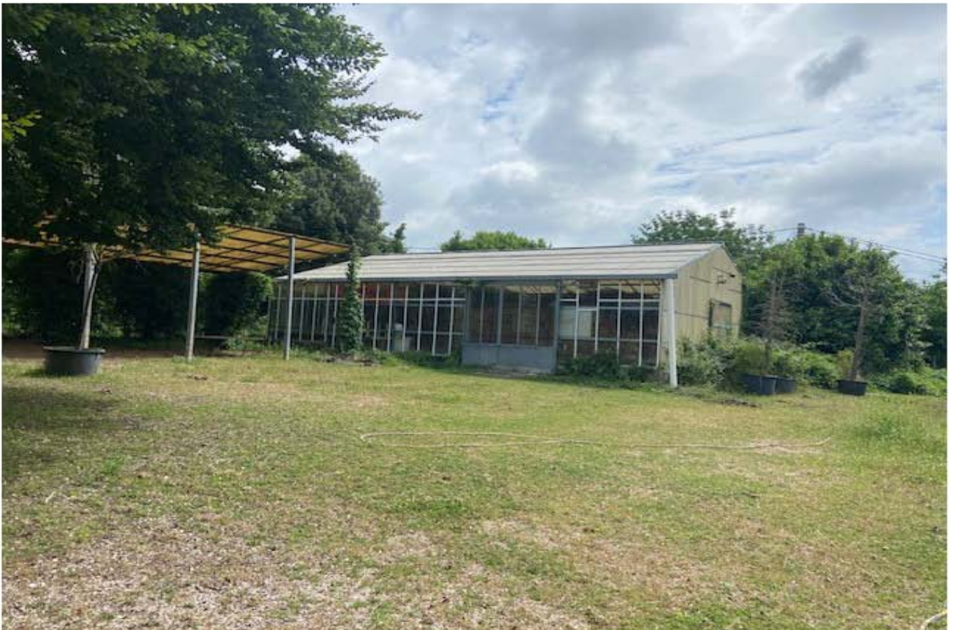
TETTOIA VELLETRI P.LLA 769 E SERRA VELLETRI P.LLA 634
