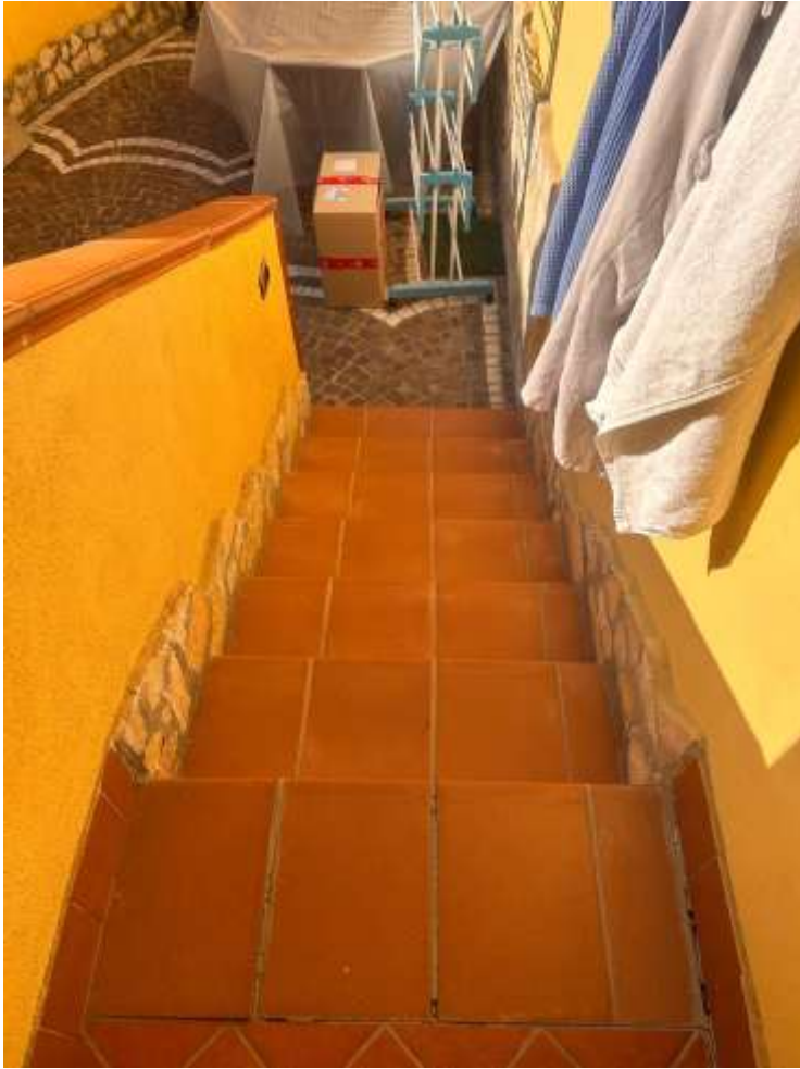
Foto 11 - Rampa di scale che conduce ad un ballatoio
