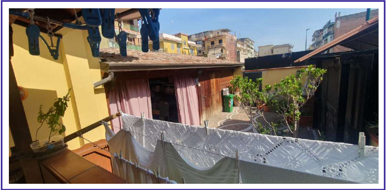
Foto n° 9,10-Superando un dislivello di circa 90 cm si arriva ad un terrazzino coperto da cui si accede all'appartamento
