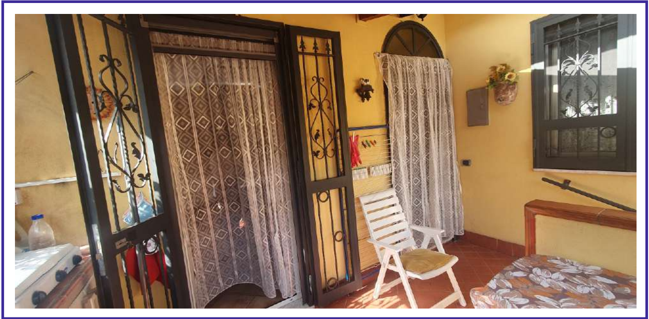
Foto n° 11-Ingresso all'unità immobiliare con accesso dal civico 1.
