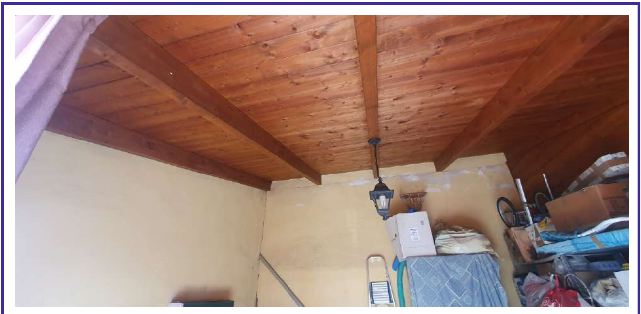
Foto n° 6 - Tettoia in legno a quota piano di calpestio chiusa su tre lati
