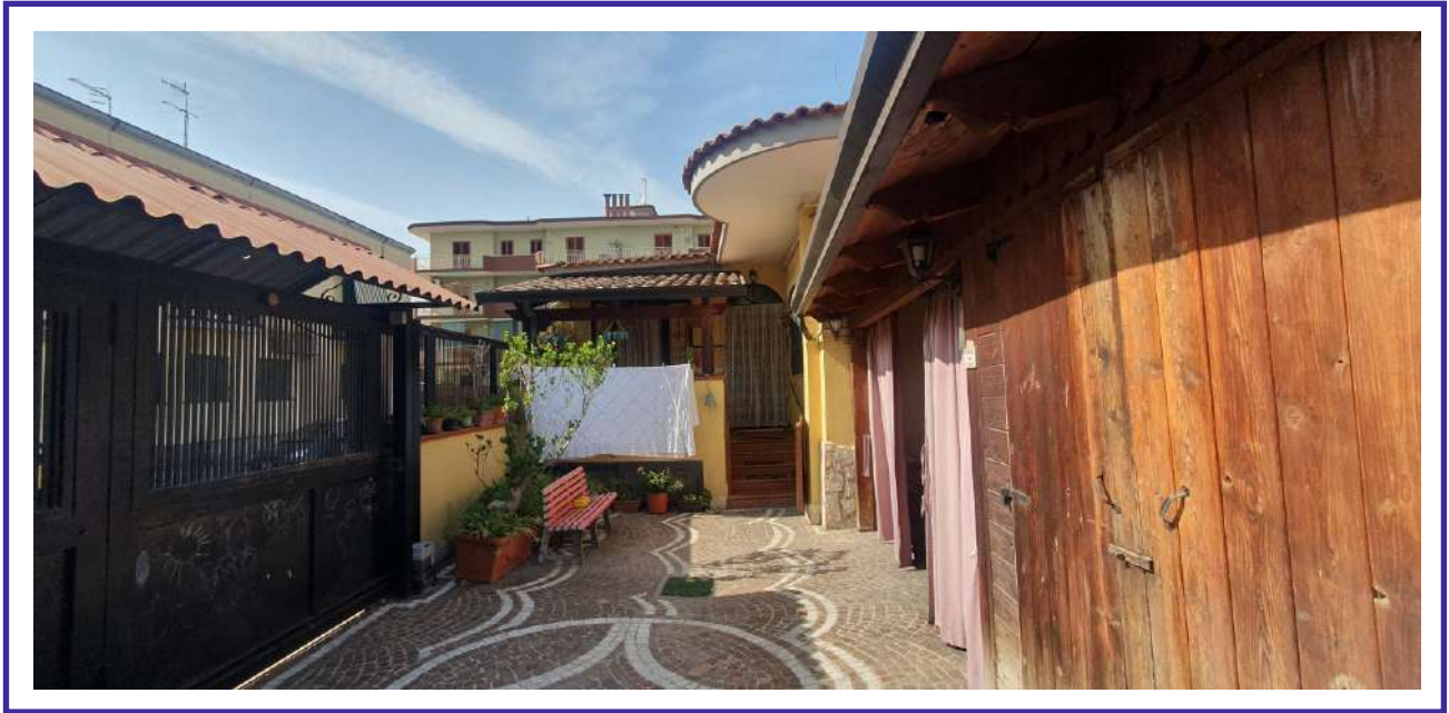
Foto n° 5-Sulla destra sono visibili una tettoia chiusa su tre lati ed un'altro ambiente chiuso su 4 lati con una porta in legno
