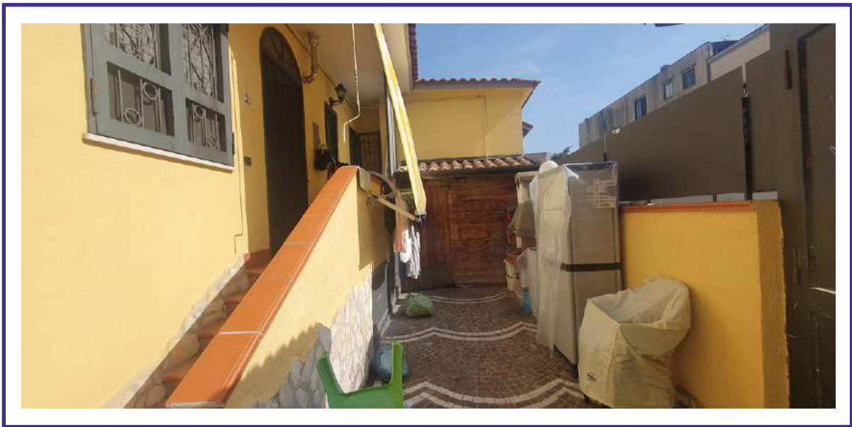
Foto n° 21,22-Ingresso alla seconda unità immobiliare ricavata dal frazionamento abusivo con ingresso dal civico n°2
