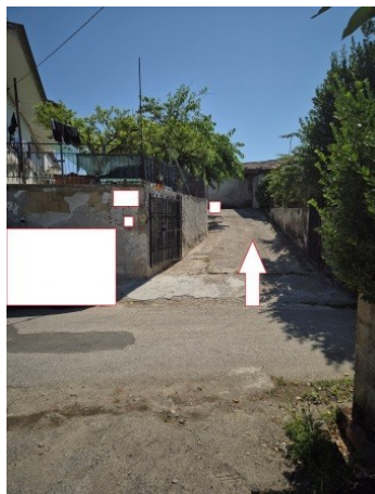
Figura 6 accesso al fabbricato indipendente mediante la rampa carrabile su via Borgo Vittorio snc in Carinola
