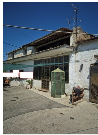
Figura 7 facciata sud del fabbricato indipendente con l'appartamento al piano terra
