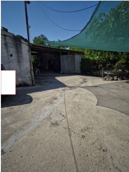
Figura 8 cortile pertinenziale al LOTTO UNICO
