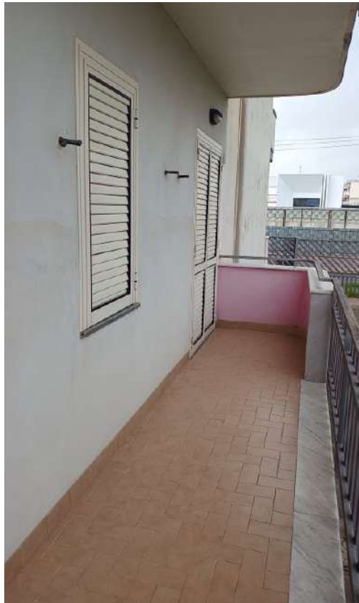
FOTO N. 5 – Balcone lato Est
