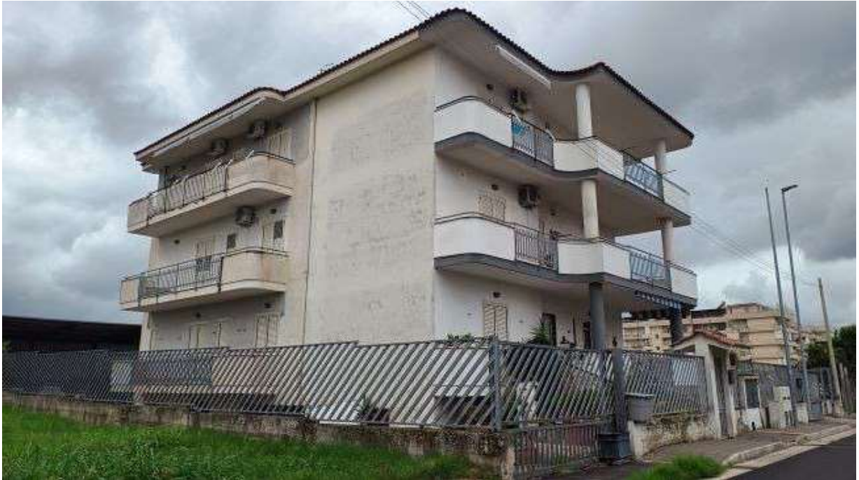
FOTO N. 1 – Il fabbricato di cui l'appartamento pignorato fa parte
