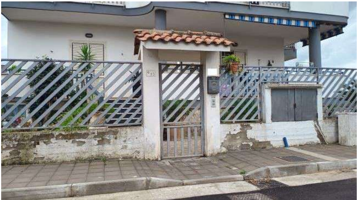
FOTO N. 2 – Cannello di ingresso del fabbricato di cui l'appartamento pignorato fa parte
