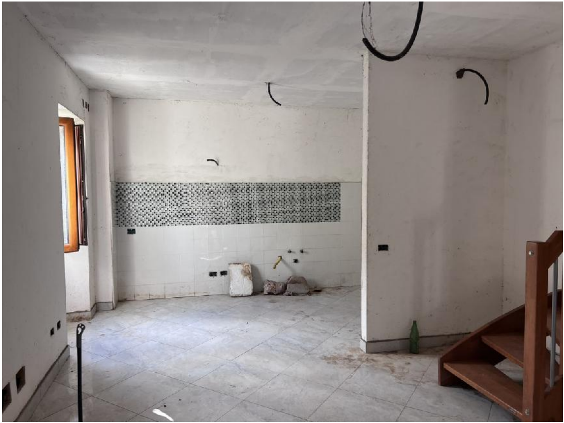
- Foto n. 7 - Vista dell'interno dell'immobile (soggiorno con angolo cottura P.T.)
