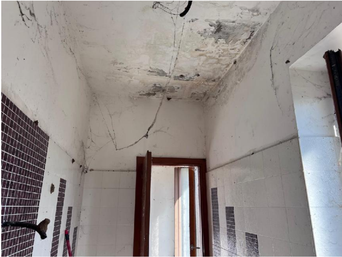
- Foto n. 13 - Vista dell'interno dell'immobile (Bagno P.1°)
