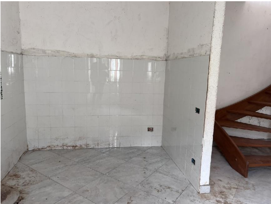
- Foto n. 6 - Vista dell'interno dell'immobile (angolo cottura P.T.)
