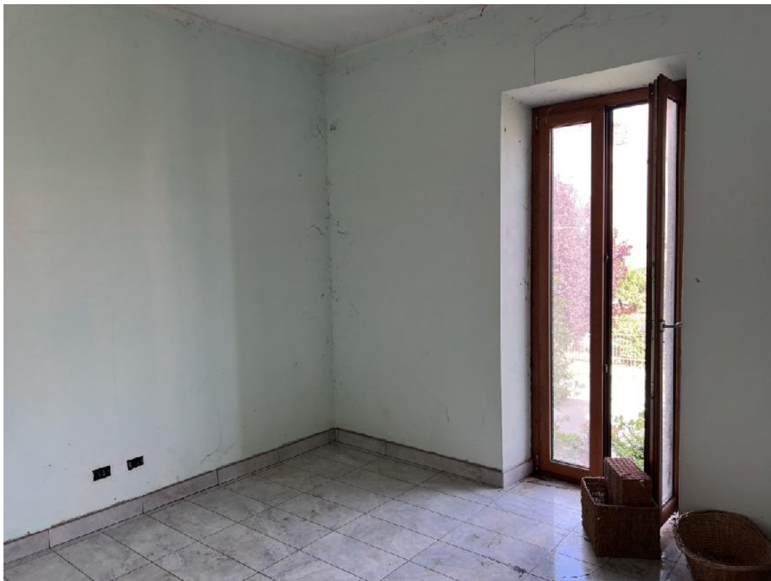
Foto n. 16 - Vista dell'interno dell'immobile (1° camera P.1°)
