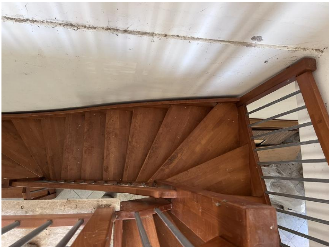
Foto n. 18 - Vista dell'interno dell'immobile (scala di accesso dal piano terra al P.1°)
