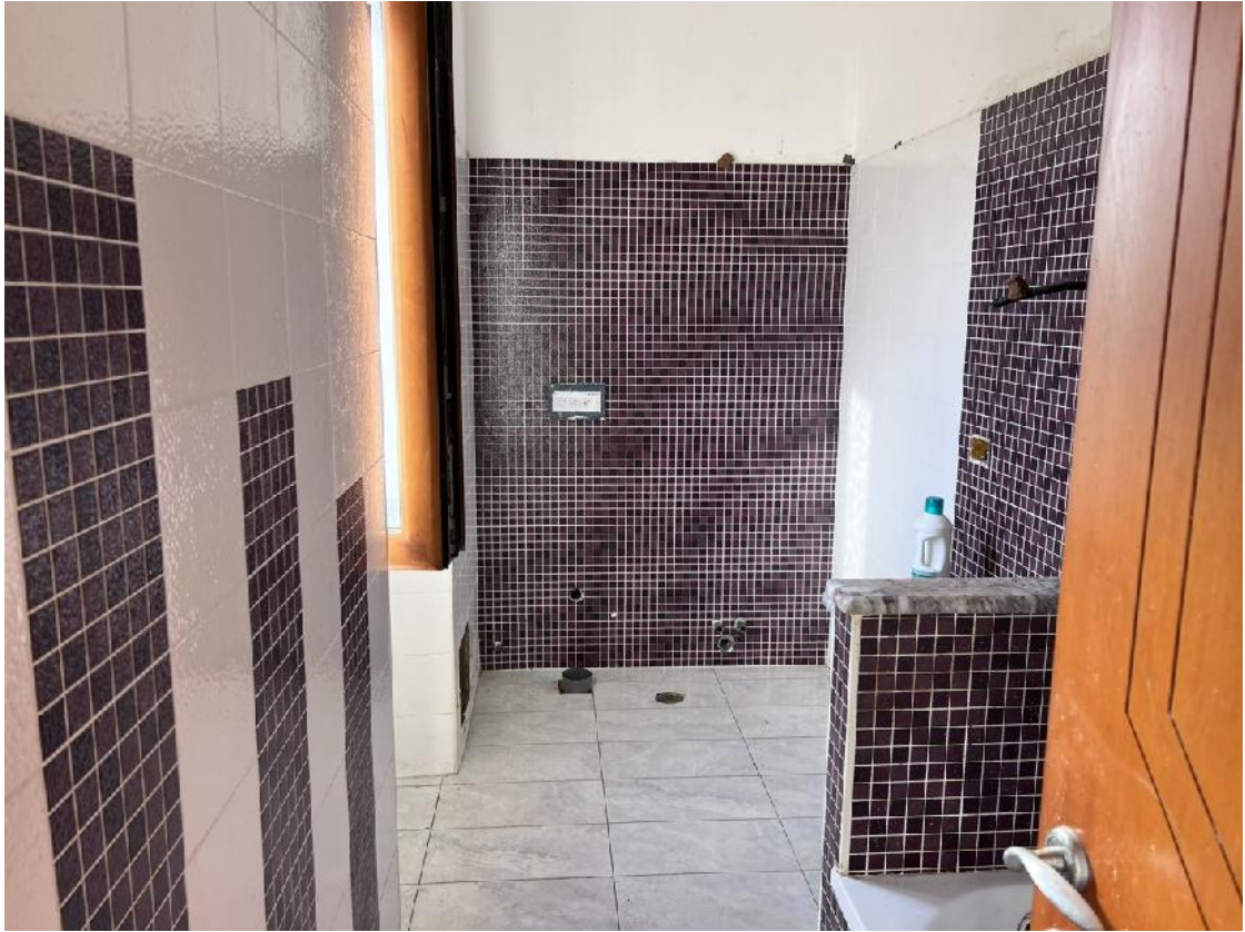
- Foto n. 11 - Vista dell'interno dell'immobile (Bagno P.1°)
