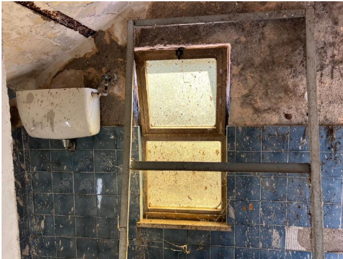
- Foto n. 10 - Vista dell'interno dell'immobile (ingresso P.T.)
