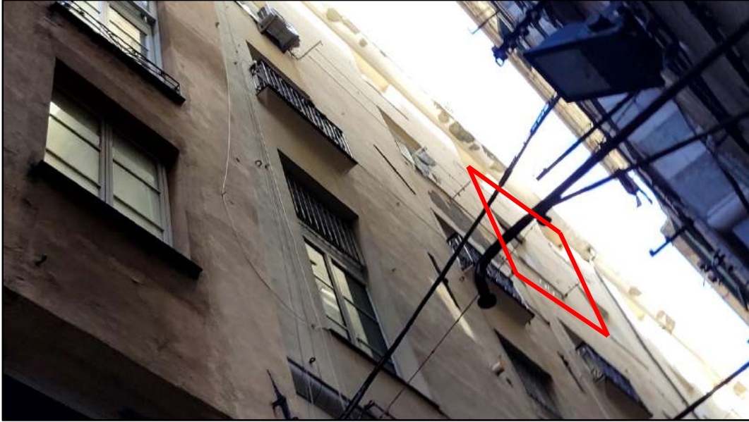
Fotografia 3 Facciata con indicazione dell'int. 13A
