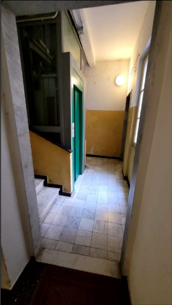
Fotografia 11 Vista del vano scala dal piano dell'immobile
