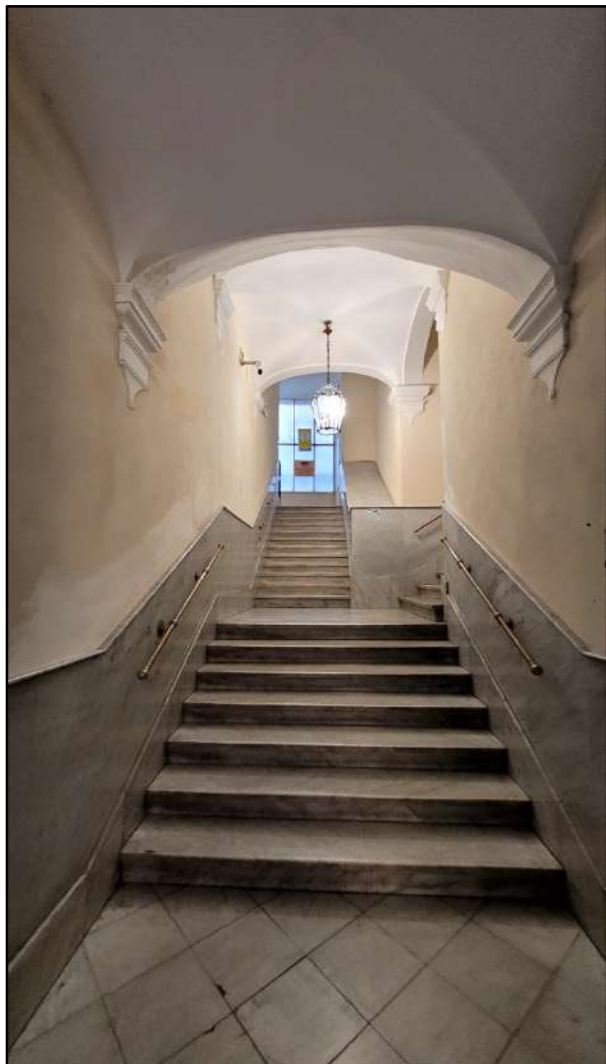
Fotografia 5 Atrio con accesso alla scala A (frontale) e alle restanti scale (rampa a destra)
