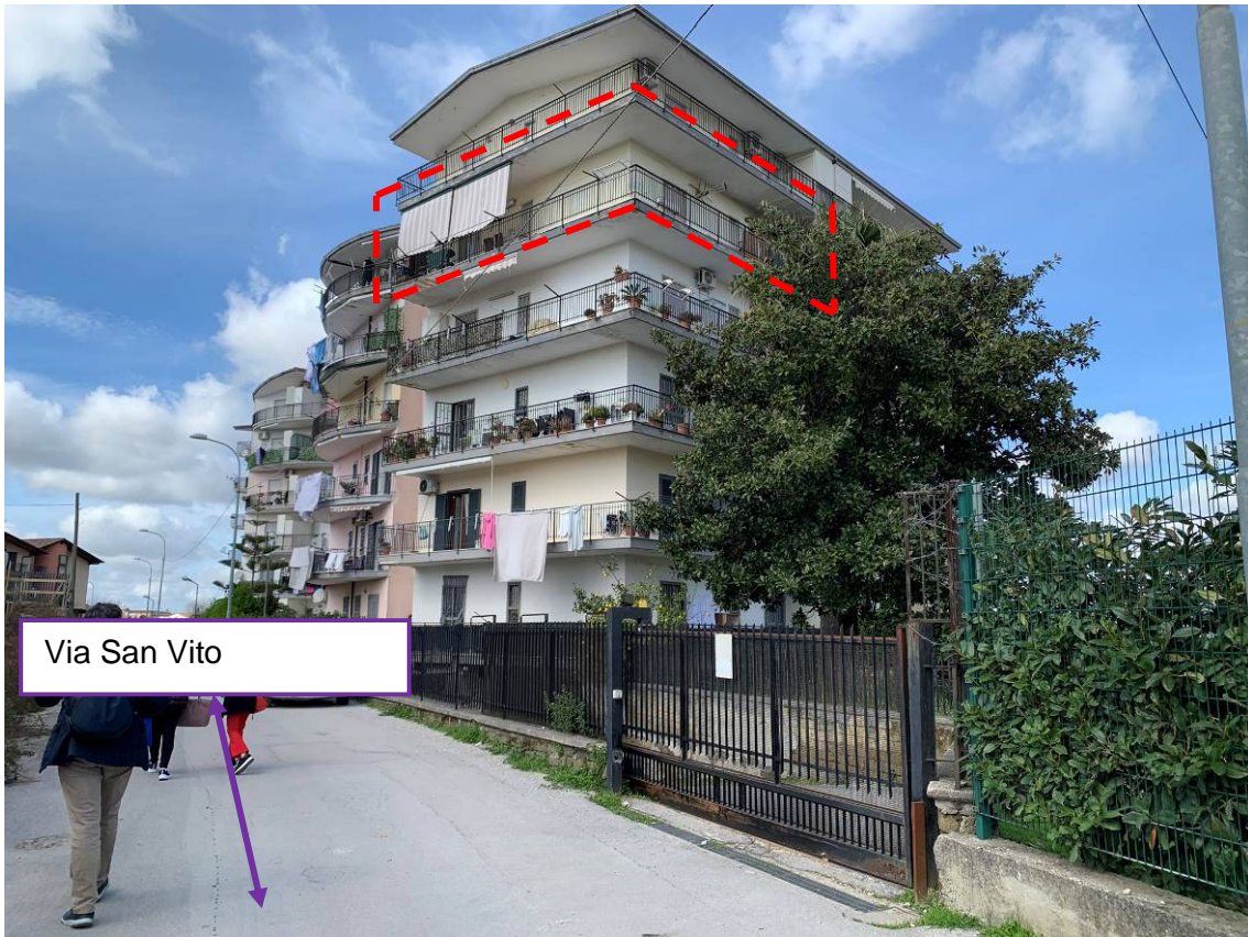
Foto 02 – Il fabbricato dalla via San Vito
