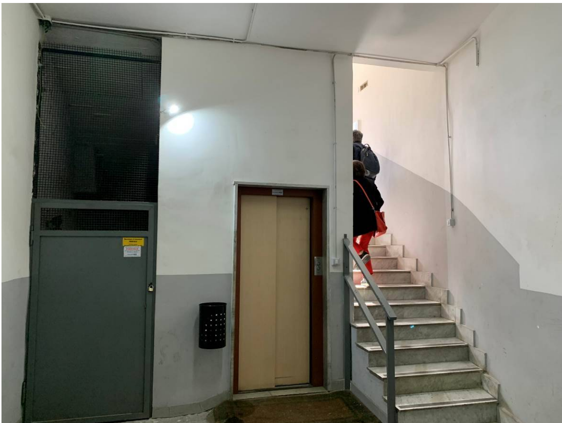
Foto 17 – Scale condominiali verso il piano seminterrato
