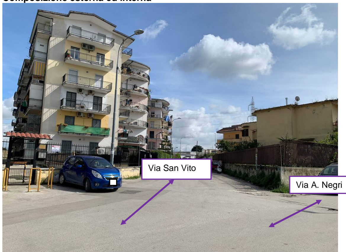
Foto 01 – Il fabbricato dalla via San Vito
