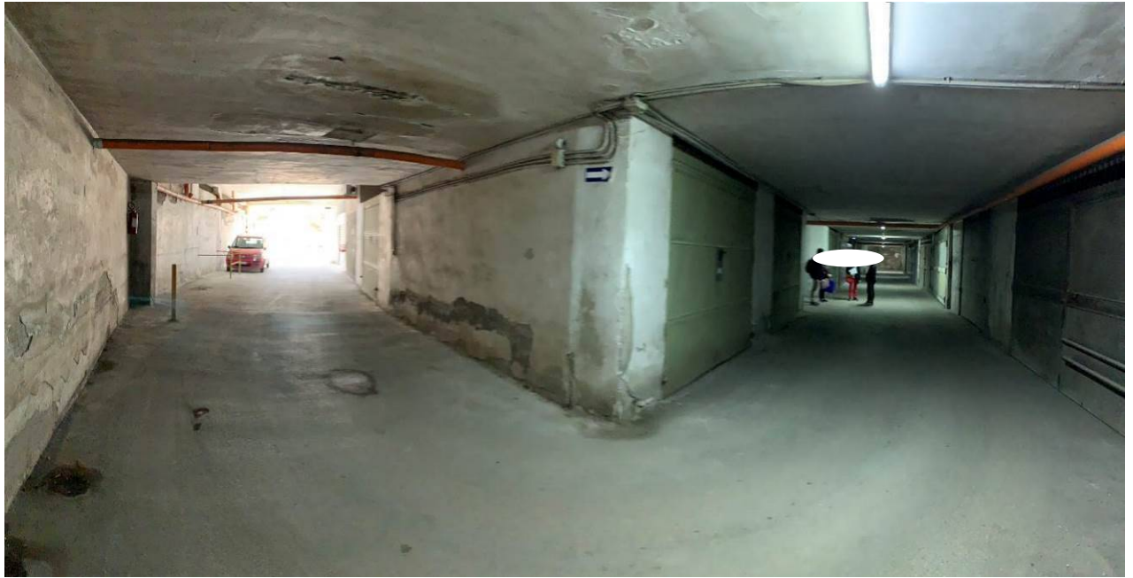
Foto 21 – Zona comune di manovra al piano seminterrato
