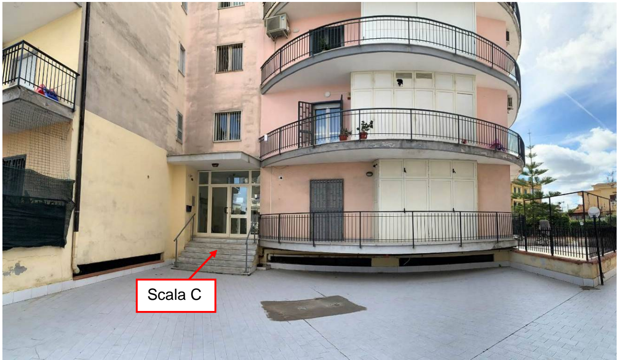
Foto 04 – L'ingresso alla scala C
