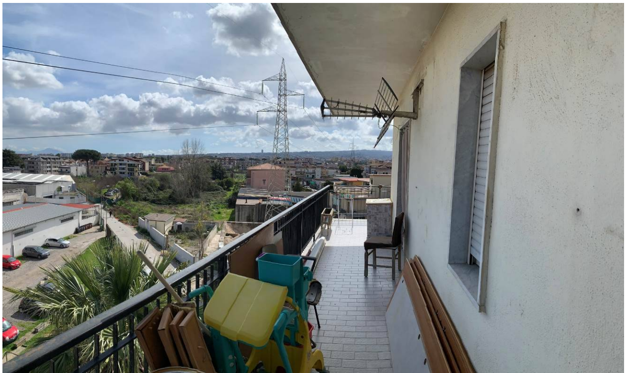
Foto 11 – Balcone b lato SudEst
